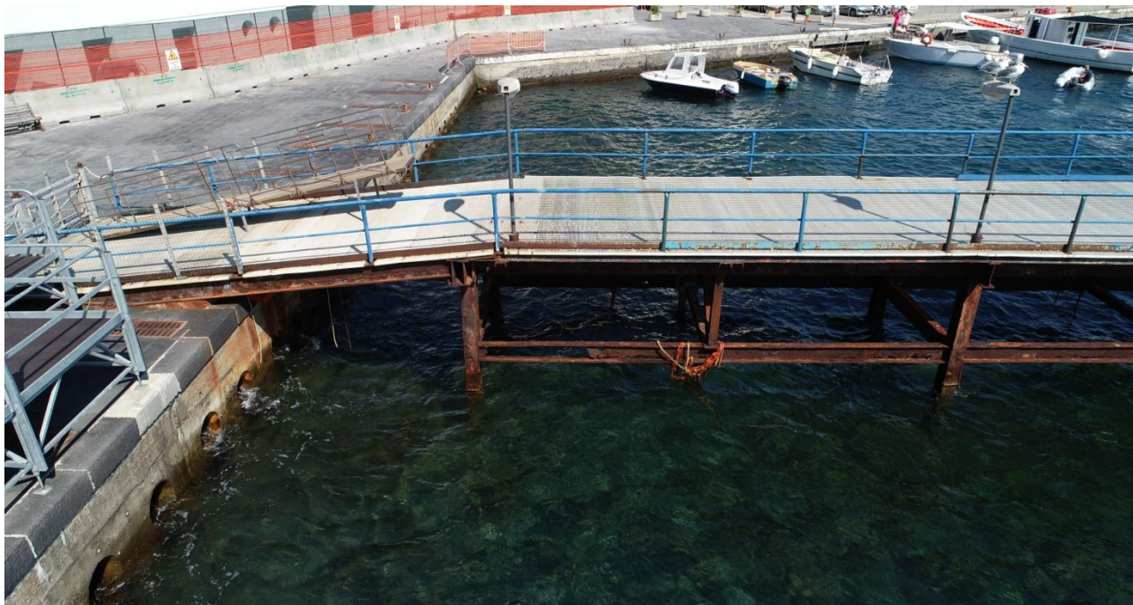
Figura 9.5 - Banchina di radice del molo aliscafi – fori sulla parete verticale
