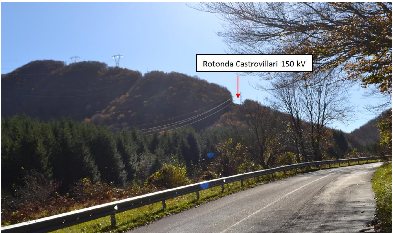
Figura 13: Fascia di taglio della vegetazione Linea da demolire Rotonda Castrovillari
