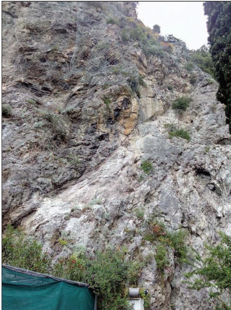
Fig. 4.7 – Particolare del contatto tettonico tra “Dolomia superiore” (in basso a destra) e i “Calcari e dolomie con selce” (in alto a sinistra dell’affioramento). Si notano diverse superfici di faglia e una “damage zone” abbastanza sviluppata.
