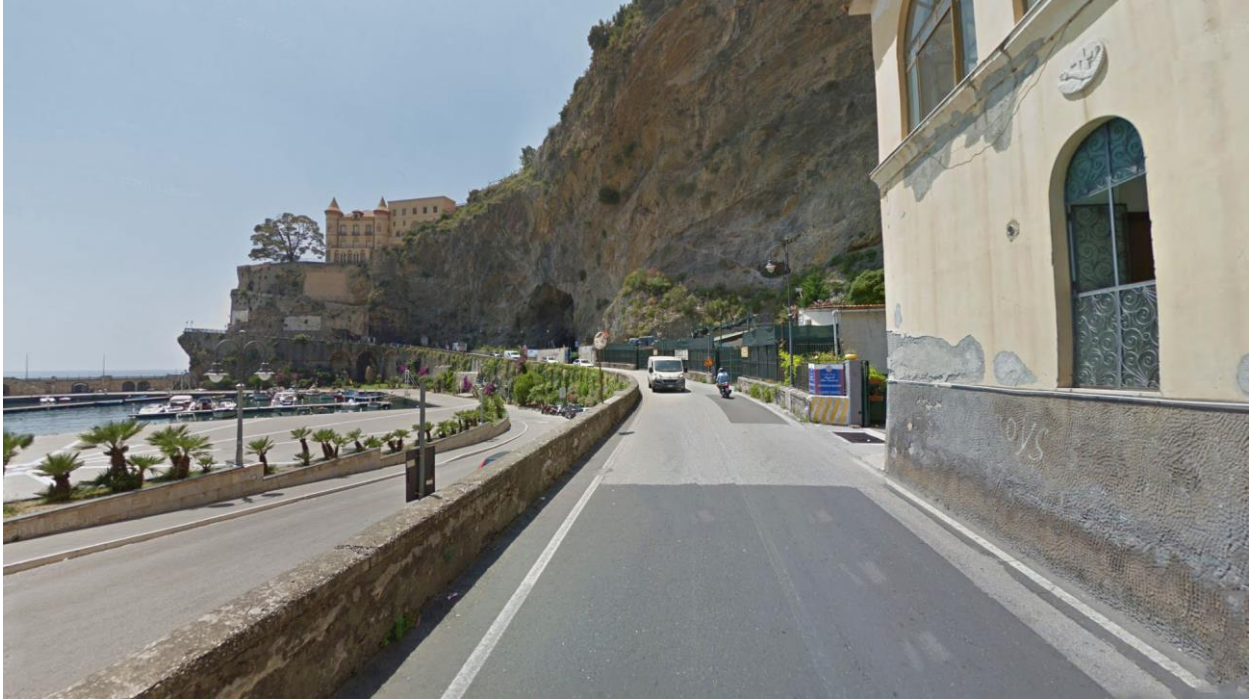
Figura 7-2 Stato attuale area imbocco galleria lato Maiori
