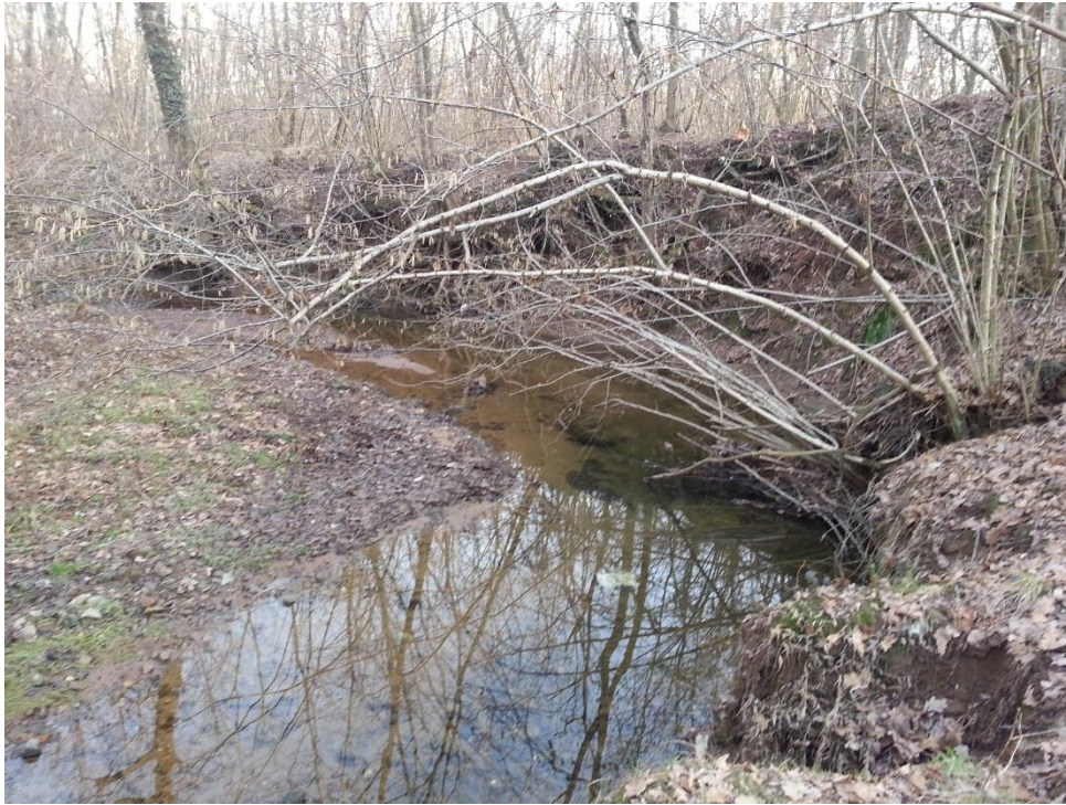
Figura 15 - Riale San Giorgio in prossimità dell'attraversamento col tracciato della "Pedemontana". Foto da sopralluogo in Gennaio 2018
