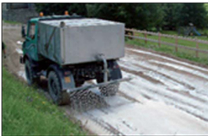
Figura 2-2 Bagnatura del rilevato
