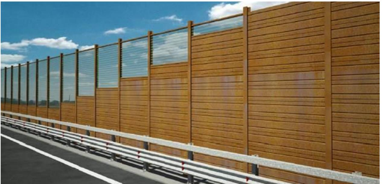
*Figura 7-6 Tipologico delle barriere acustiche previste lungo la Pedemontana piemontese*
