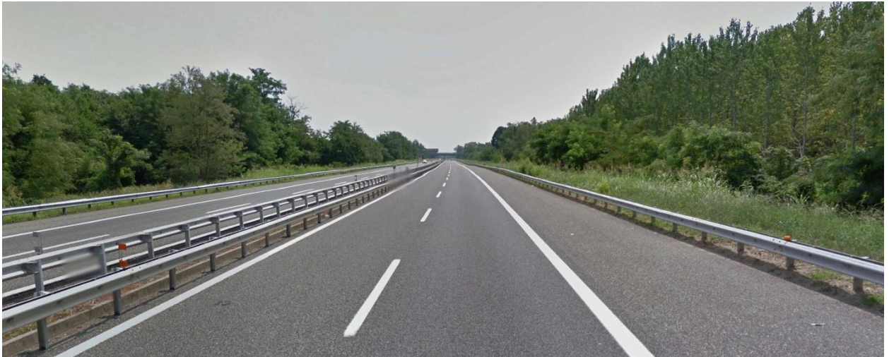
Figura 7-4 Condizioni di visibilità impossibile dalla A26
