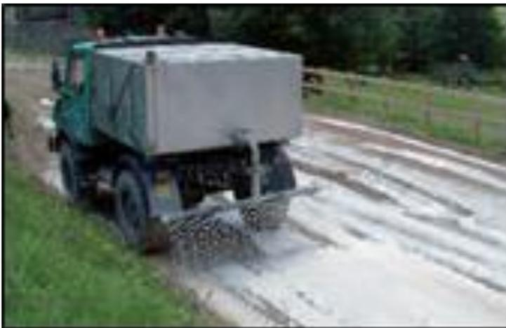
*Figura 7-2 Bagnatura del rilevato*
