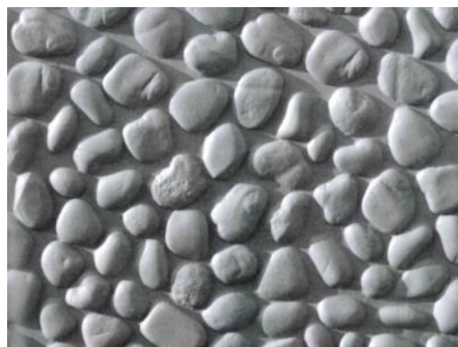
Figura 7-4 Finitura del muro di sostegno
