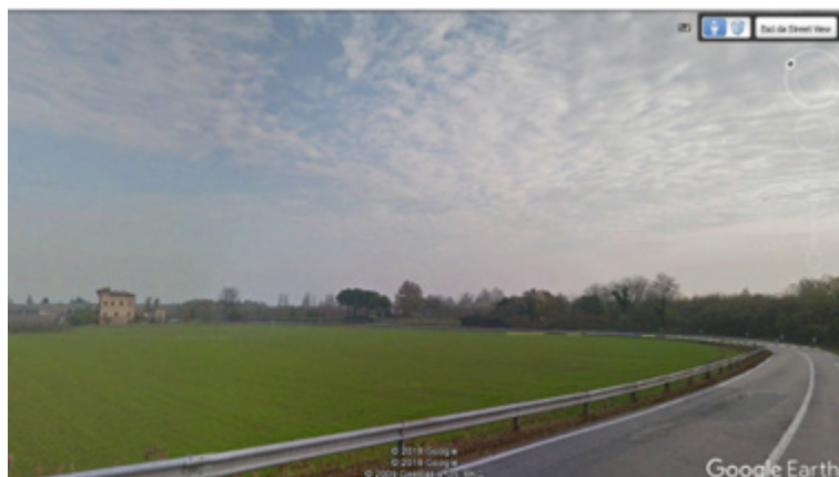
Img. 7.1.12 -Vista dell'argine del Lamone dalla SP 25
