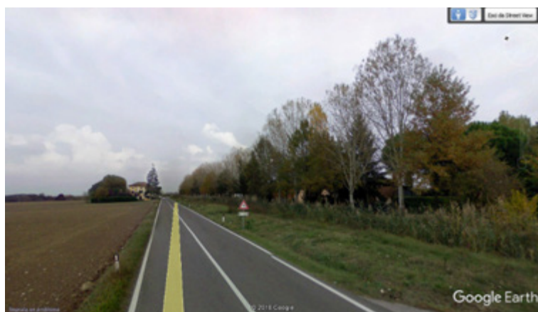
Img. 7.1.14 -Vista dello scolo consorziale Naviglio, a nord di Bagnacavallo, con l'alberata di pioppi
