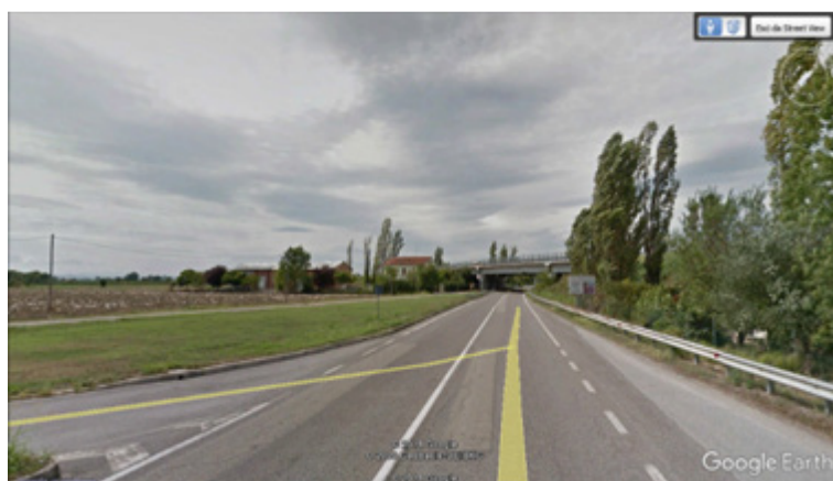
Img. 7.1.6 - Vista dell'intersezione dalla SP253 San Vitale, in direzione sudovest
