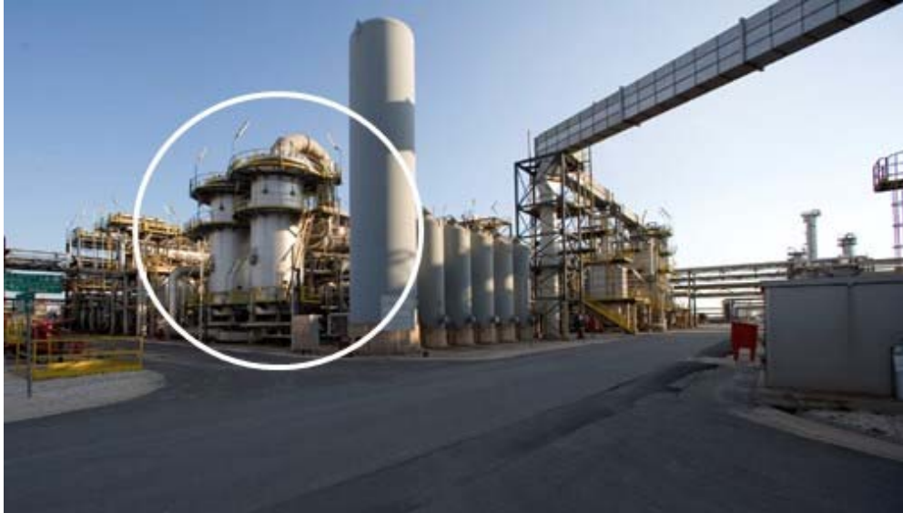
Figura 24: Individuazione dei forni Steam Reforming da smantellare (Fonte: Documentazione di progetto Eni)
