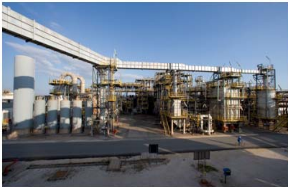
Figura 28: Foto dell'area U9400 all'interno della Raffineria (Fonte: Documentazione di progetto Eni)
