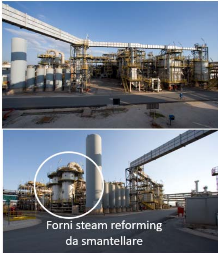
Figura 52: foto dell'area Unità 9400 in cui è prevista la realizzazione dell'impianto CPO Demo
