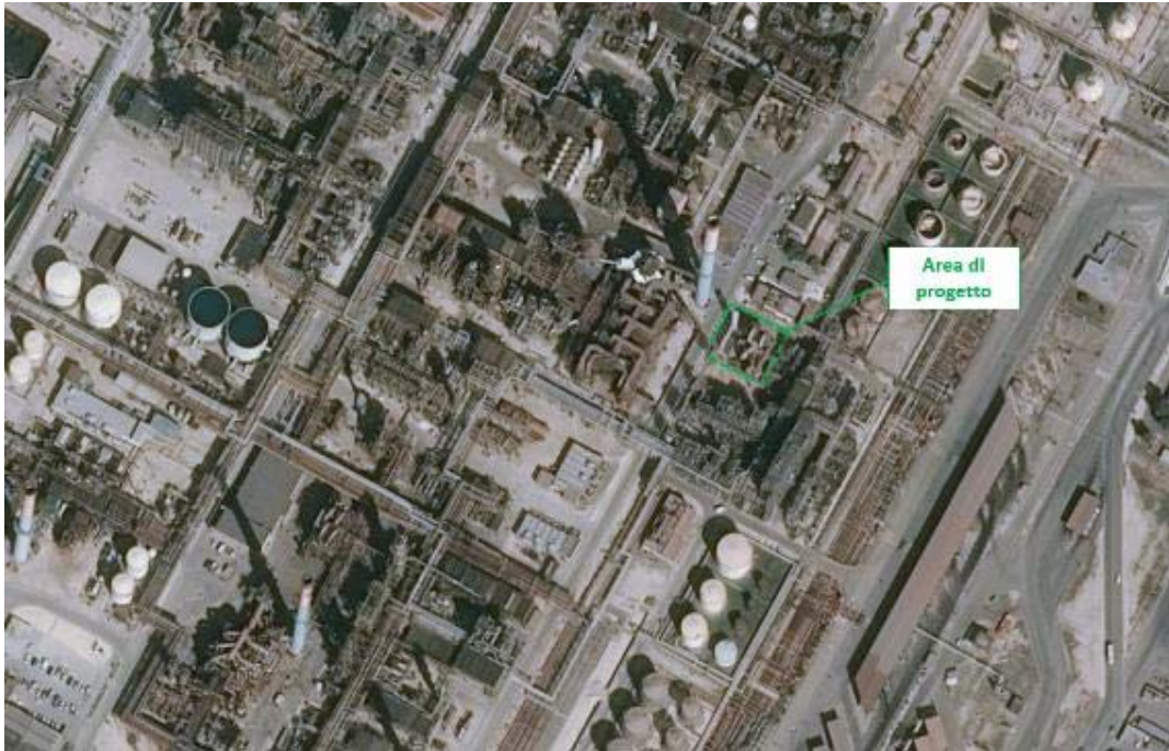
Figura 53: Vista 3D degli ingombri di alcune delle installazioni che circondano l'area di progetto
