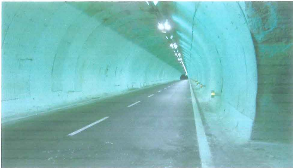
Fig. 4.1 – Galleria con rasante fotocatalitico ed illuminazione supplementare UV-A
