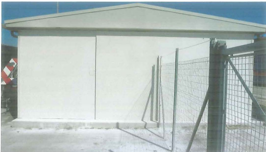
Fig. 4.2 – Applicazione di prova del rasante su box di servizio
