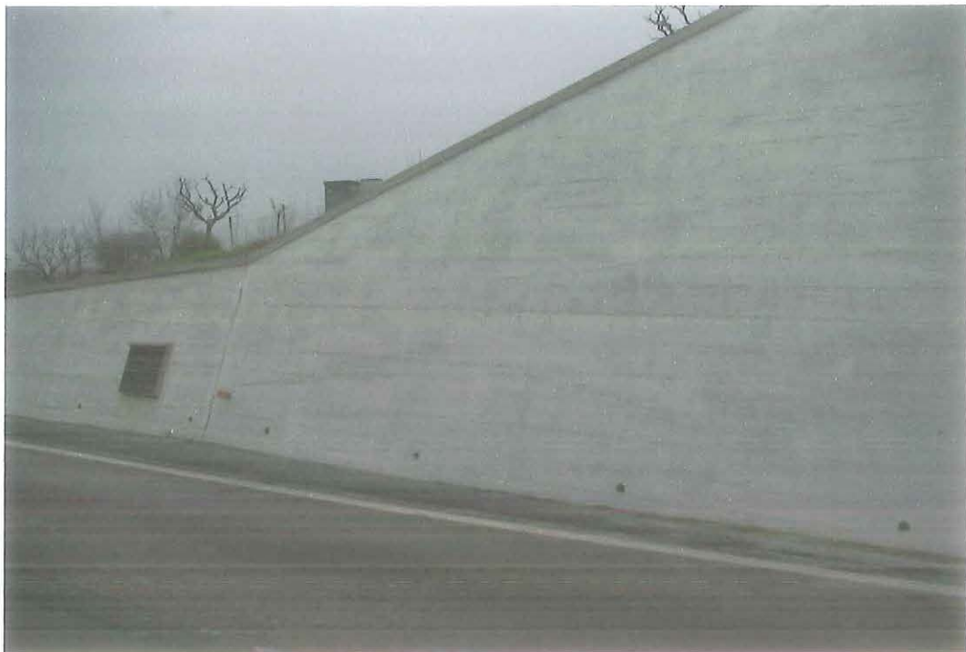
Fig. 2.11 – Pannello n° 1, carreggiata nord, 20/01/2010
