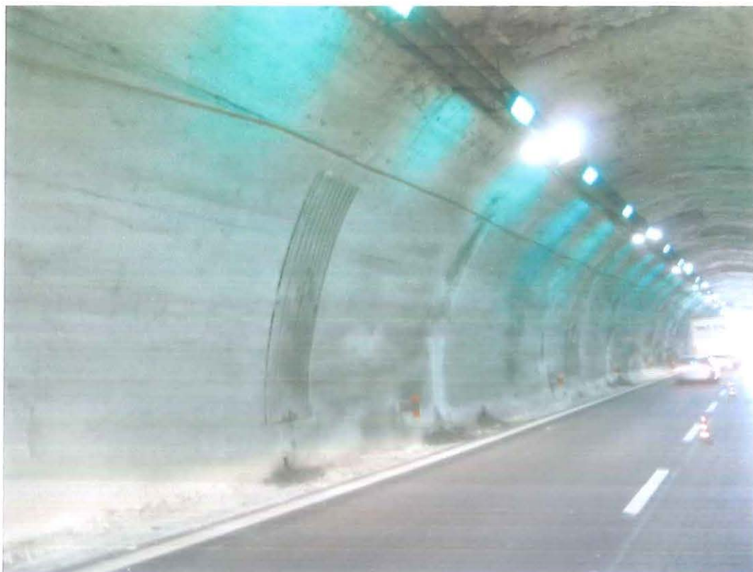
Fig. 4.28 – Galleria Nord, lato corsia di sorpasso
