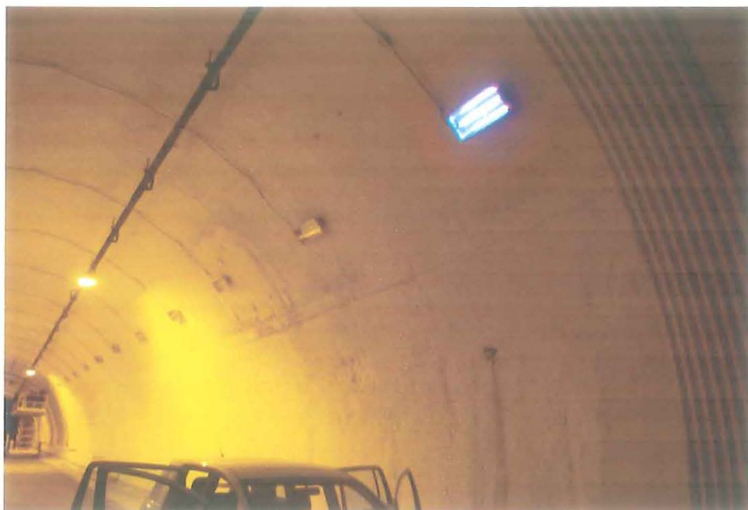
Fig. 2.8 – Lampada UV-A, prova accensione, carreggiata nord, 13/11/2009
