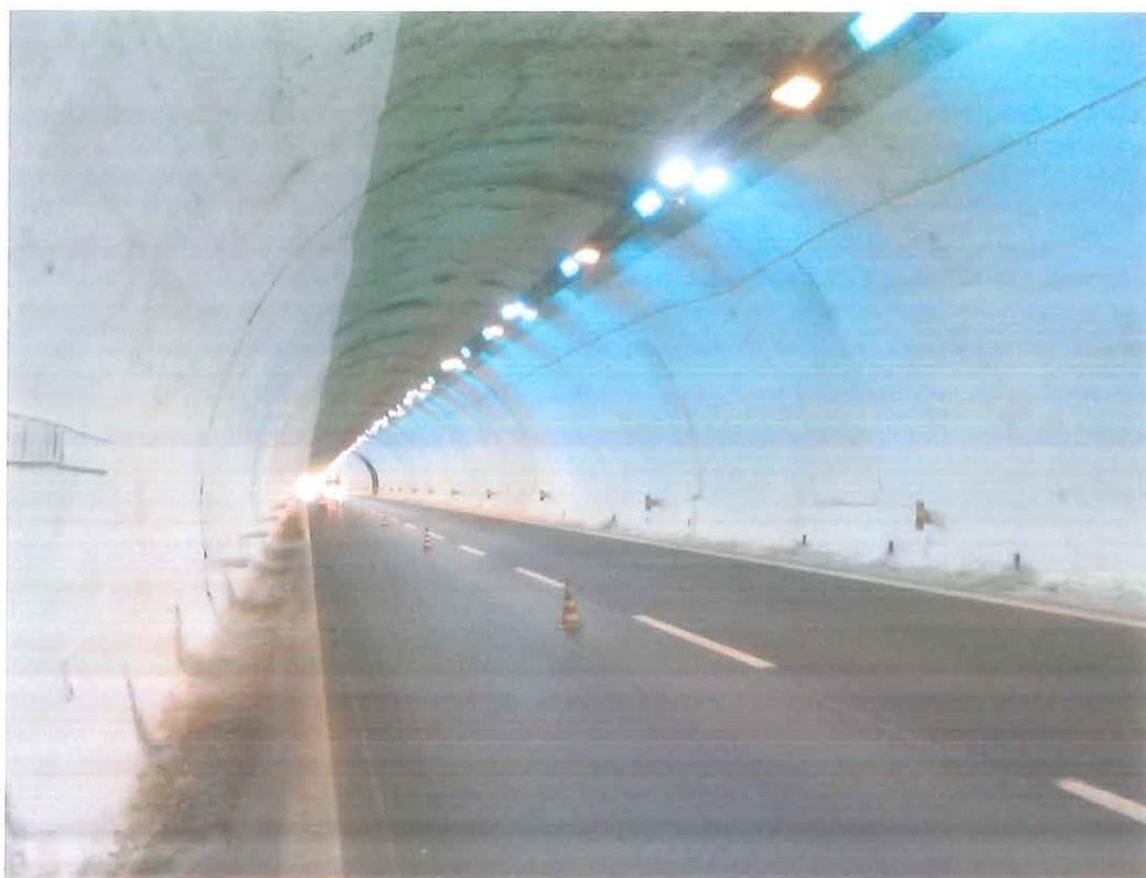
Fig. 3.1 – Galleria nord, pittura fotocatalitica della 2° fase applicata
