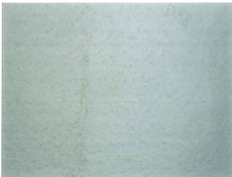
Fig. 4.23 – Particolare del rasante applicato su piedritto
