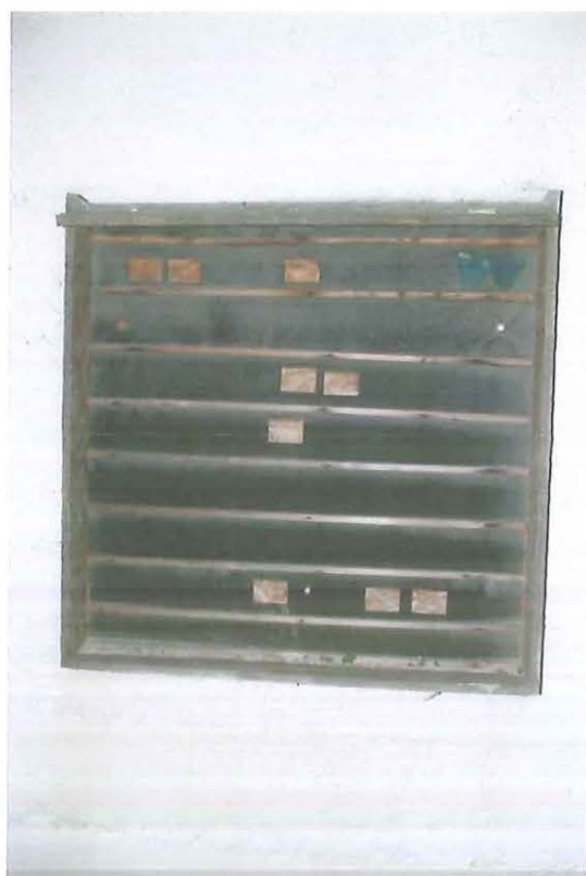
Fig. 2.9 – Pannello n° 1, carreggiata nord, 13/11/2009
