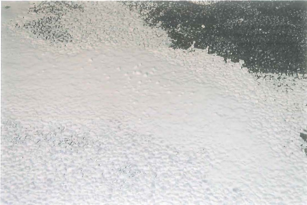
Fig. 5.3 – Intasamento del tappeto poroso con boiacca cementizia fotocatalitica
