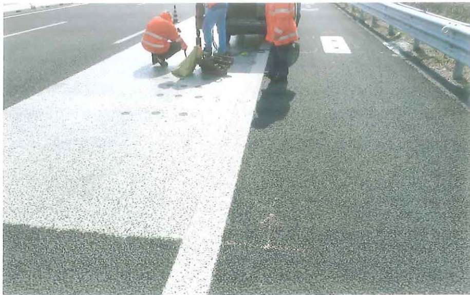
Fig. 5.2 – Una delle aree trattate con prodotti fotocatalitici
