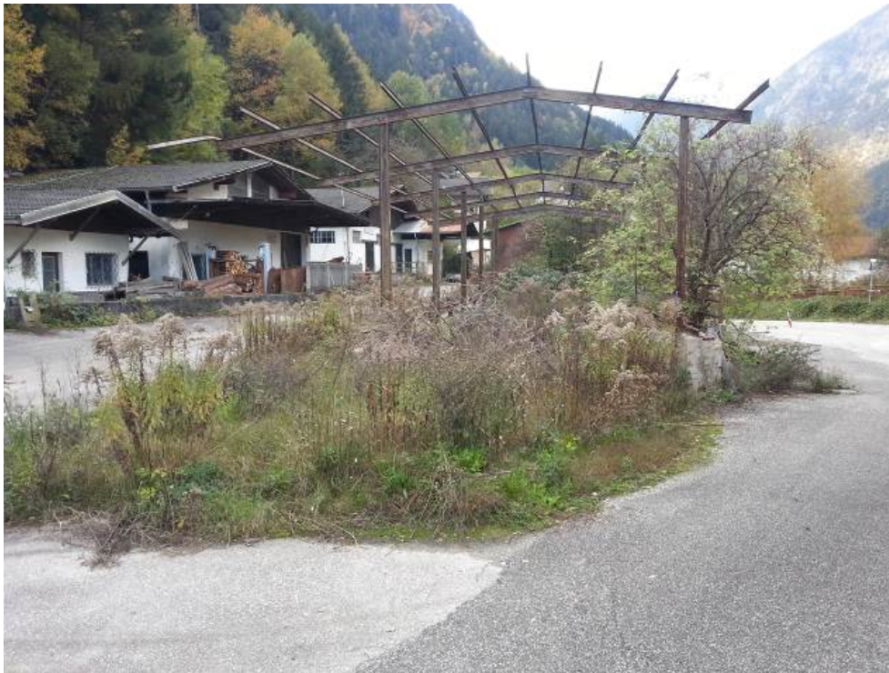
Stahlskelett von Objekt B.
