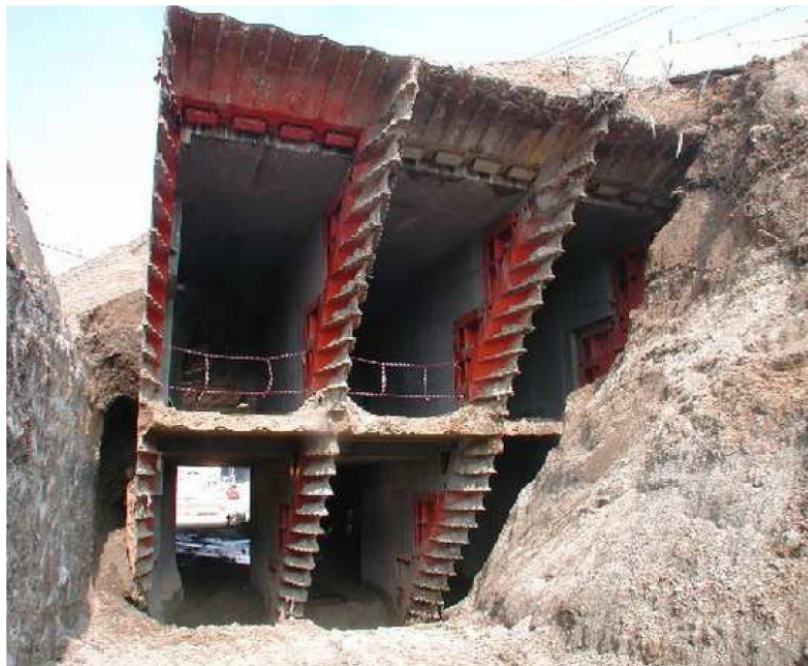
Vista dal vero dello scudo metallico (sistema UCS) Beispielabbildung des Metallschildes (UCS-System)
