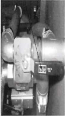
Figura 1 – Valvola regolatrice
