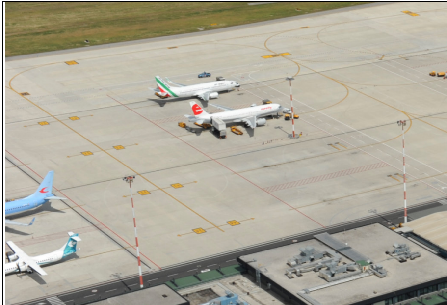
Figura 4.6.2 – Torri faro per illuminazione piazzale aeromobili
