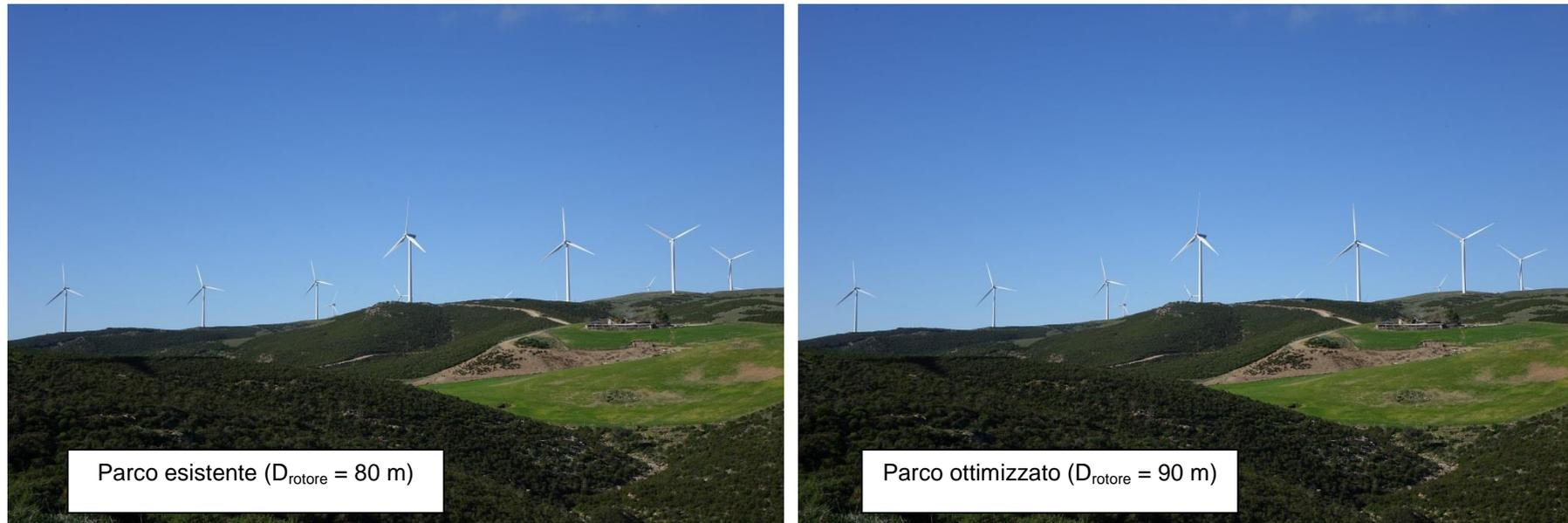
Figura 22: Punto di ripresa P.S. 1 – Distanza 1° Aerogeneratore visibile ~ 900 m: Raffronto tra parco eolico esistente e parco ottimizzato ( $D_{\text{rotore}} = 80 \text{ m}$  vs  $D_{\text{rotore}} = 90 \text{ m}$ ).
