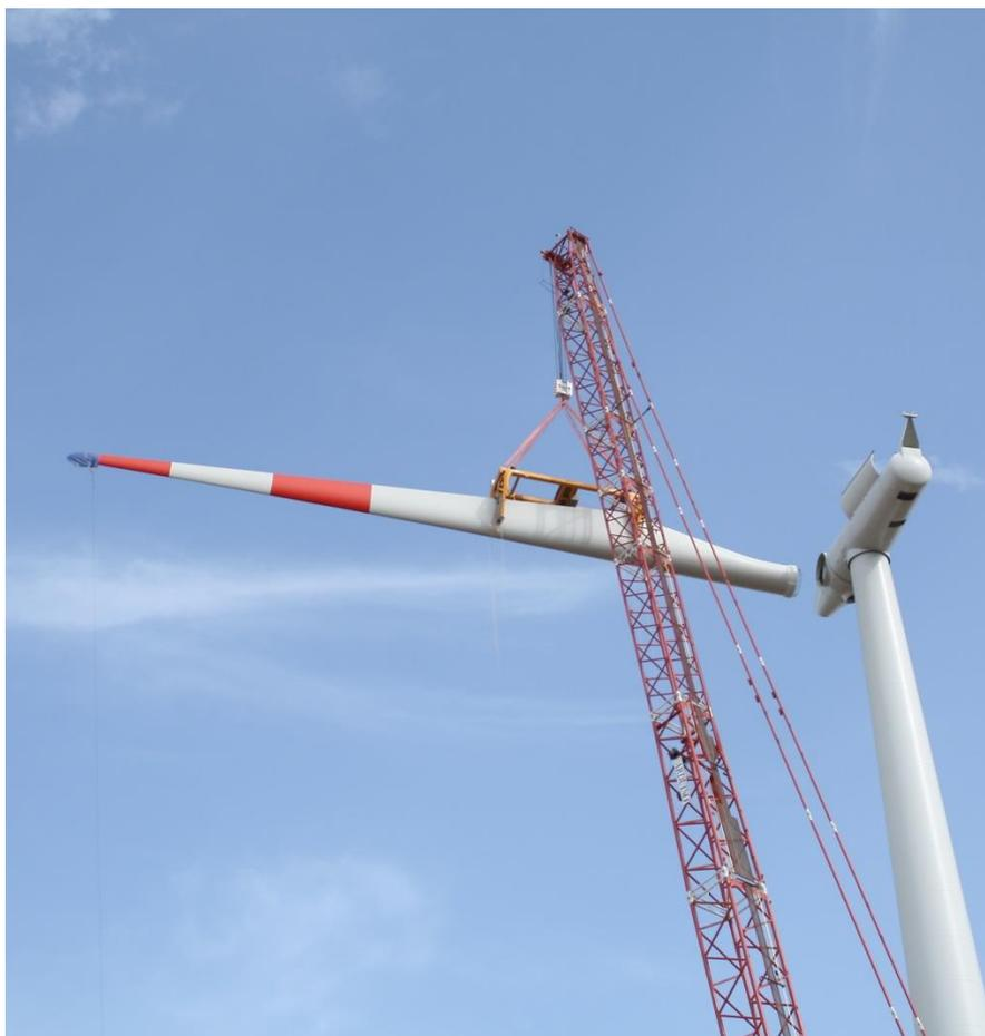
Figura 6 – Schema della fase di montaggio in quota delle pale di un aerogeneratore di caratteristiche simili a quelli installati nel parco eolico di Ulassai
