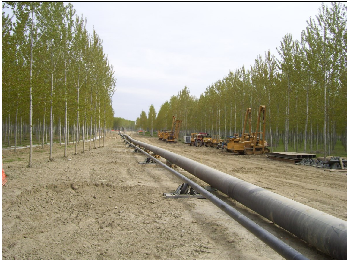
Fig. 2.7/D: Attrav. F. Po con met. 30" – Colonna della pipeline preassemblata sulla pista di varo
