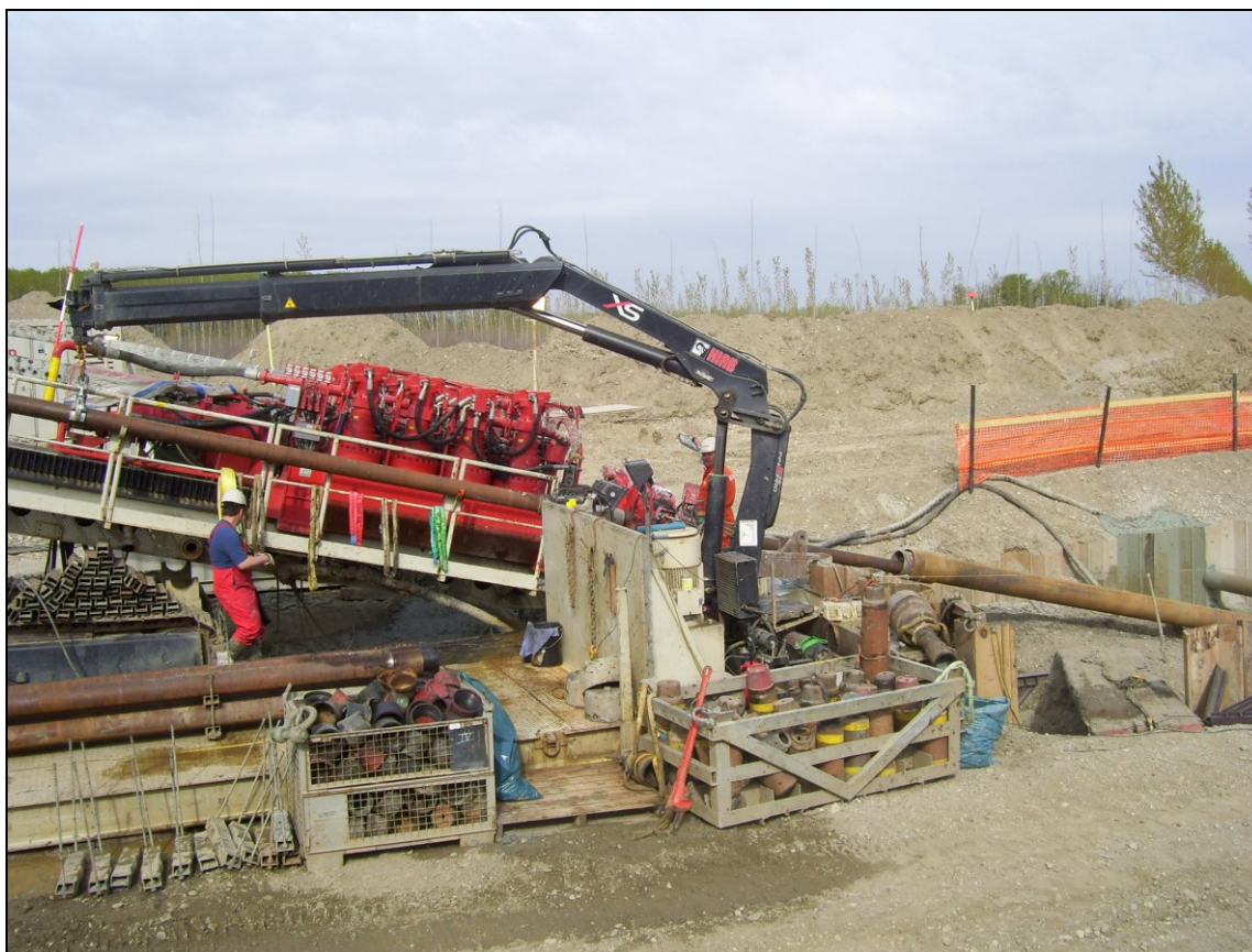
Fig. 2.7/B: Attraversamento F. Po con met. 30" – "Rig", durante la realizzazione del foro pilota
