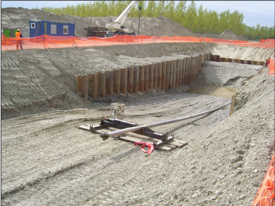
Fig. 2.7/C: Attraversamento F. Po con met. 30" – fase di uscita dell'asta pilota
