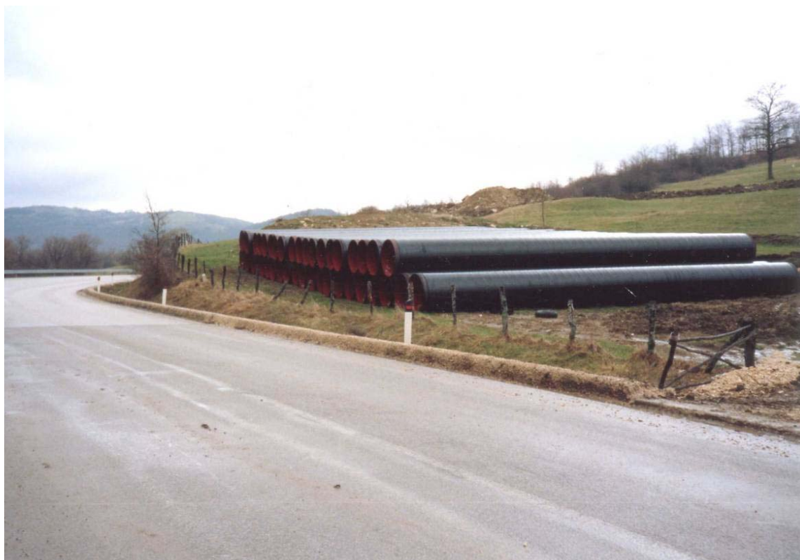
Foto 3.B: Esempio di piazzola di accatastamento tubazioni
