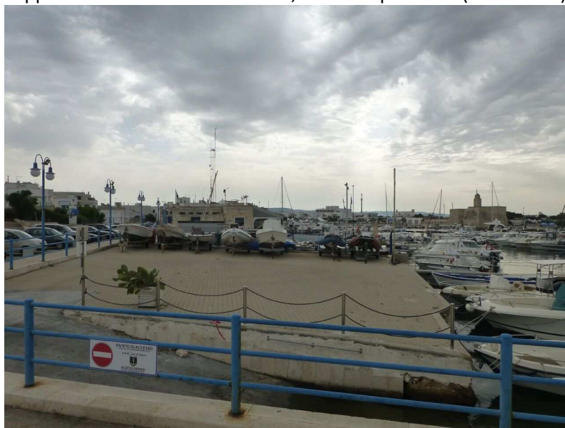
Foto 2- Particolare della ringhiera limite demaniale
