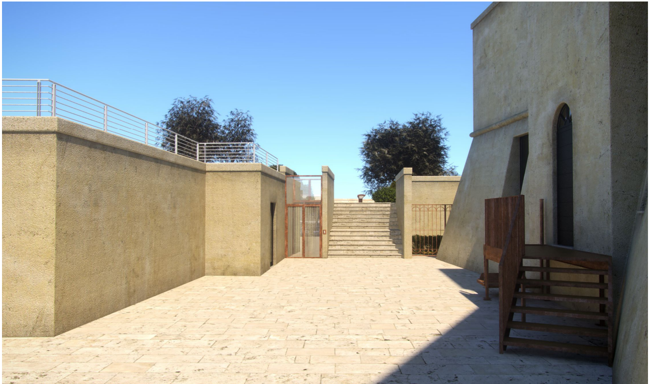
La piazzetta antistante l'ingresso alla Torre e i collegamenti verticali con le aree a monte
