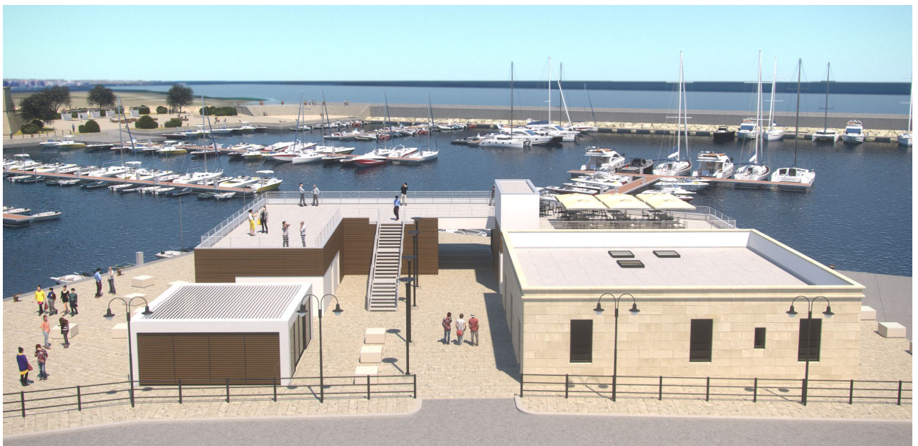
Il Centro Servizi
