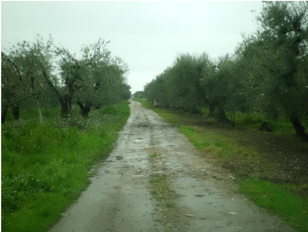
FOTO 3: STRADA DA ADEGUARE PER VS1
