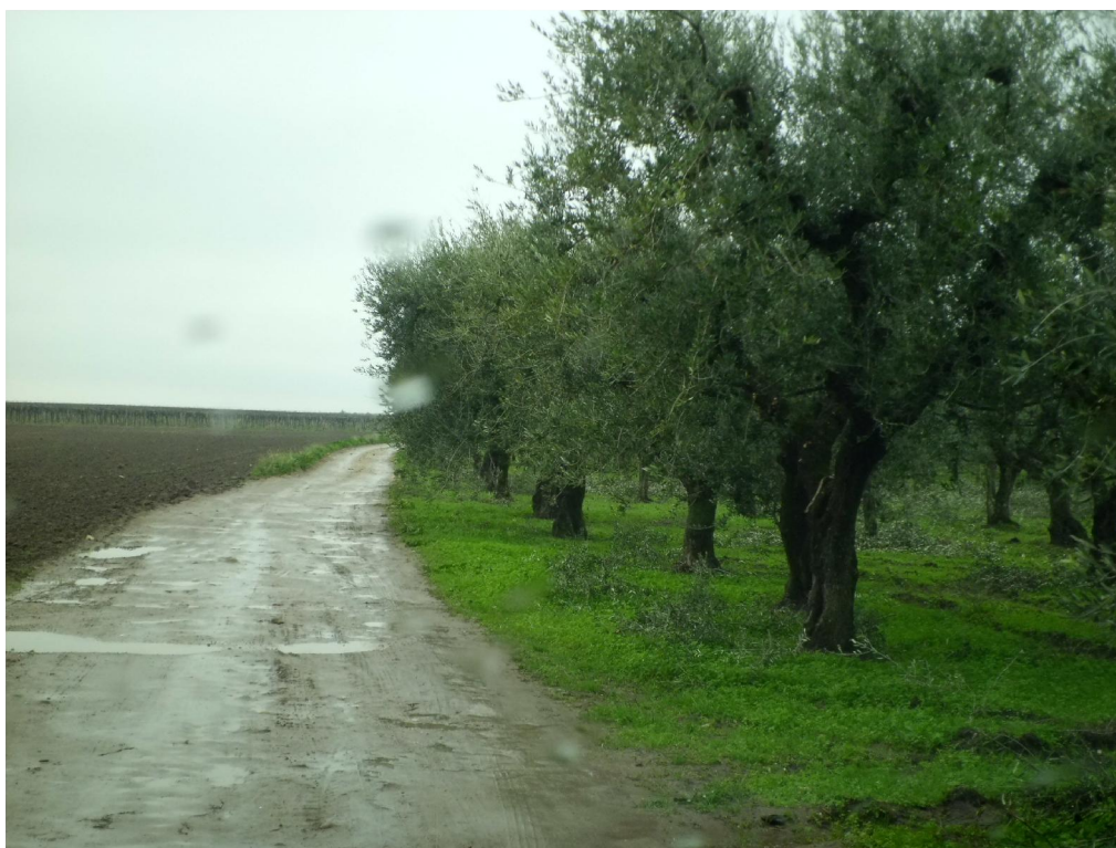
FOTO 6: VERSO LA VS4 STRADELLA DA ADEGUARE
