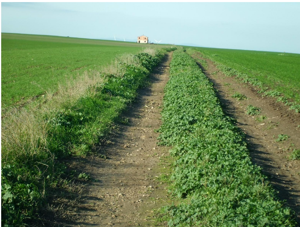
FOTO 47: VS 17 STRADA DA ADEGUARE
