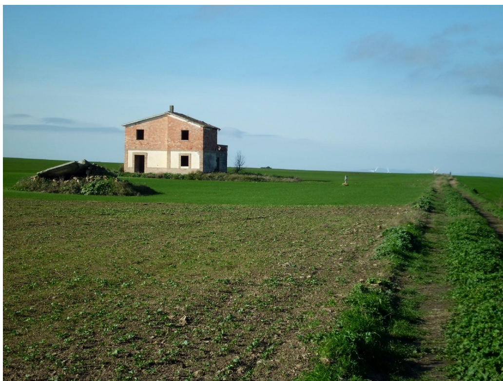
FOTO 48 AREA INTERESSATA DALL'AEREOGENERATORE VS 17
