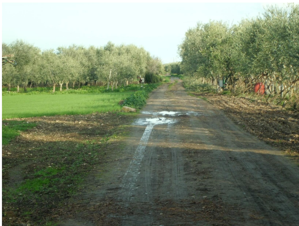
FOTO 2: STRADA DA ADEGUARE PER VS1
