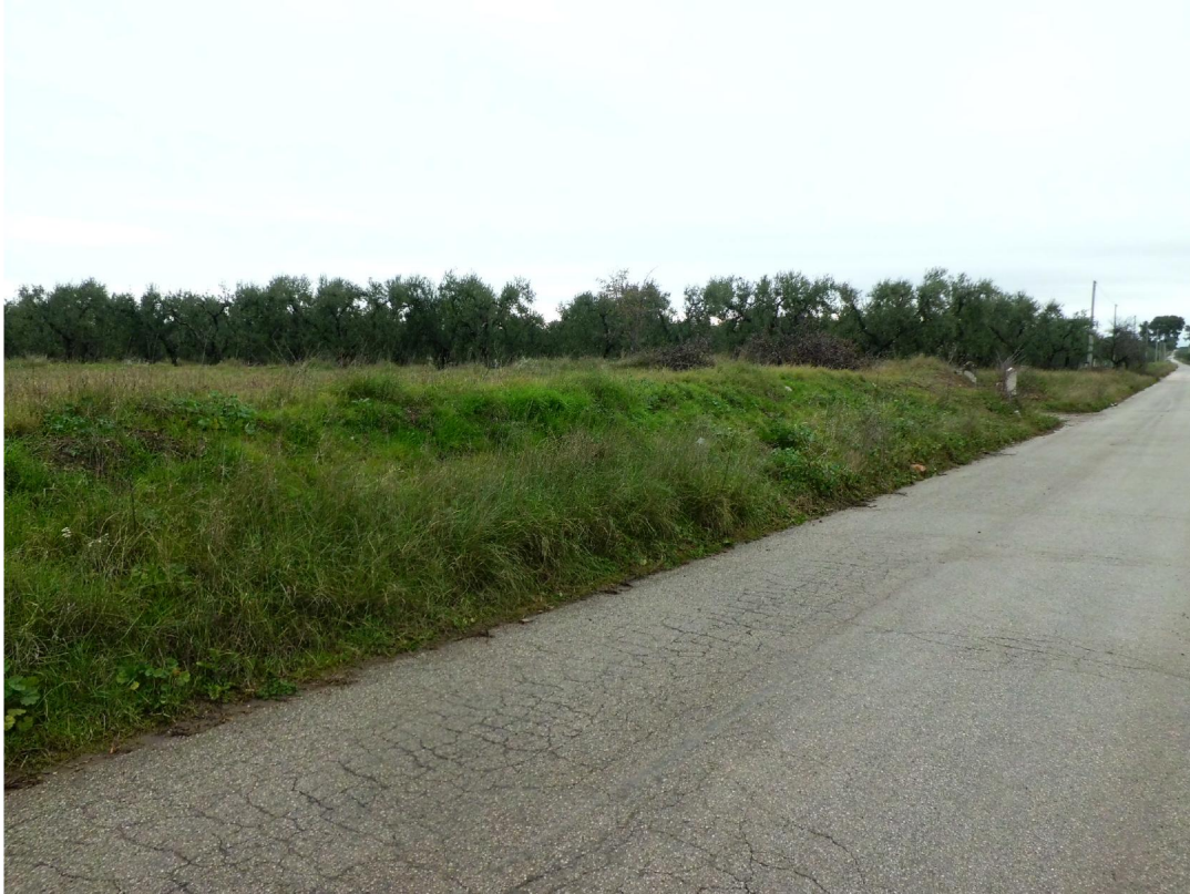
FOTO 29: VERSO LA VS13 STRADA DA ADEGUARE SVOLTA
