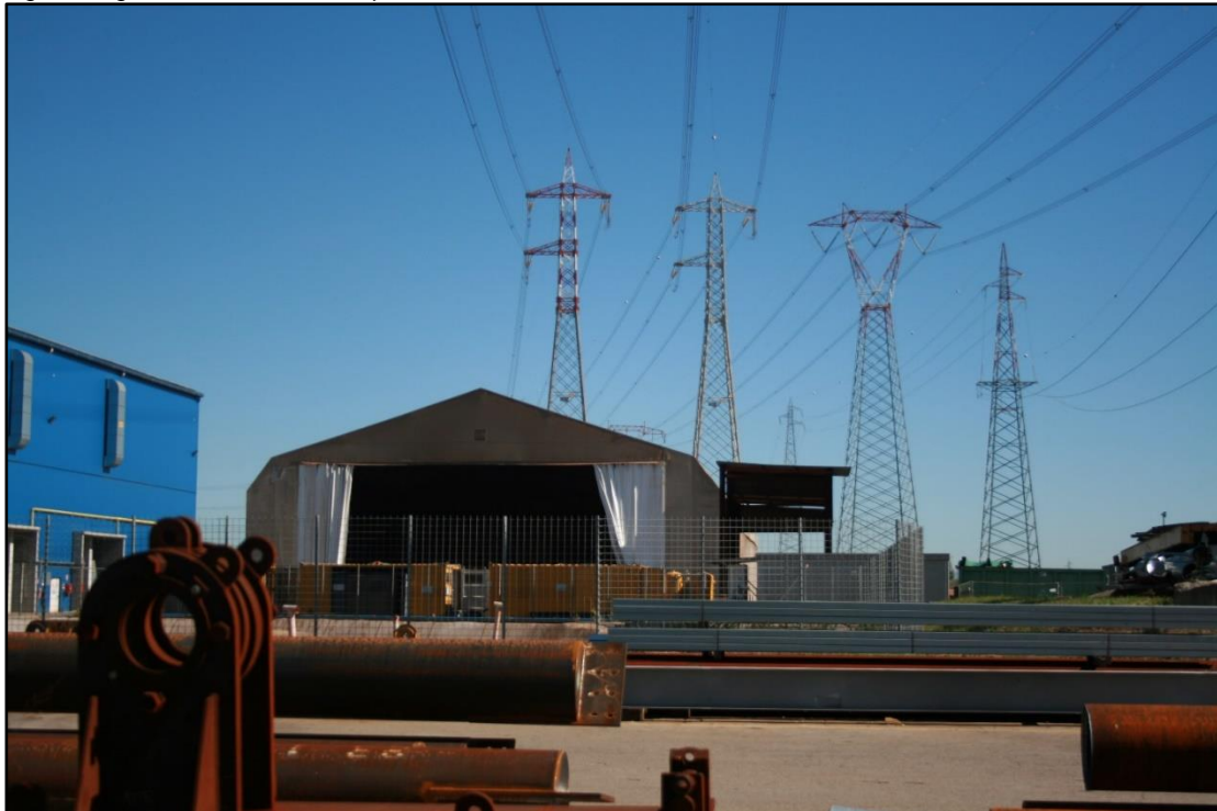
Figura 3.1g Vista locale deposito
