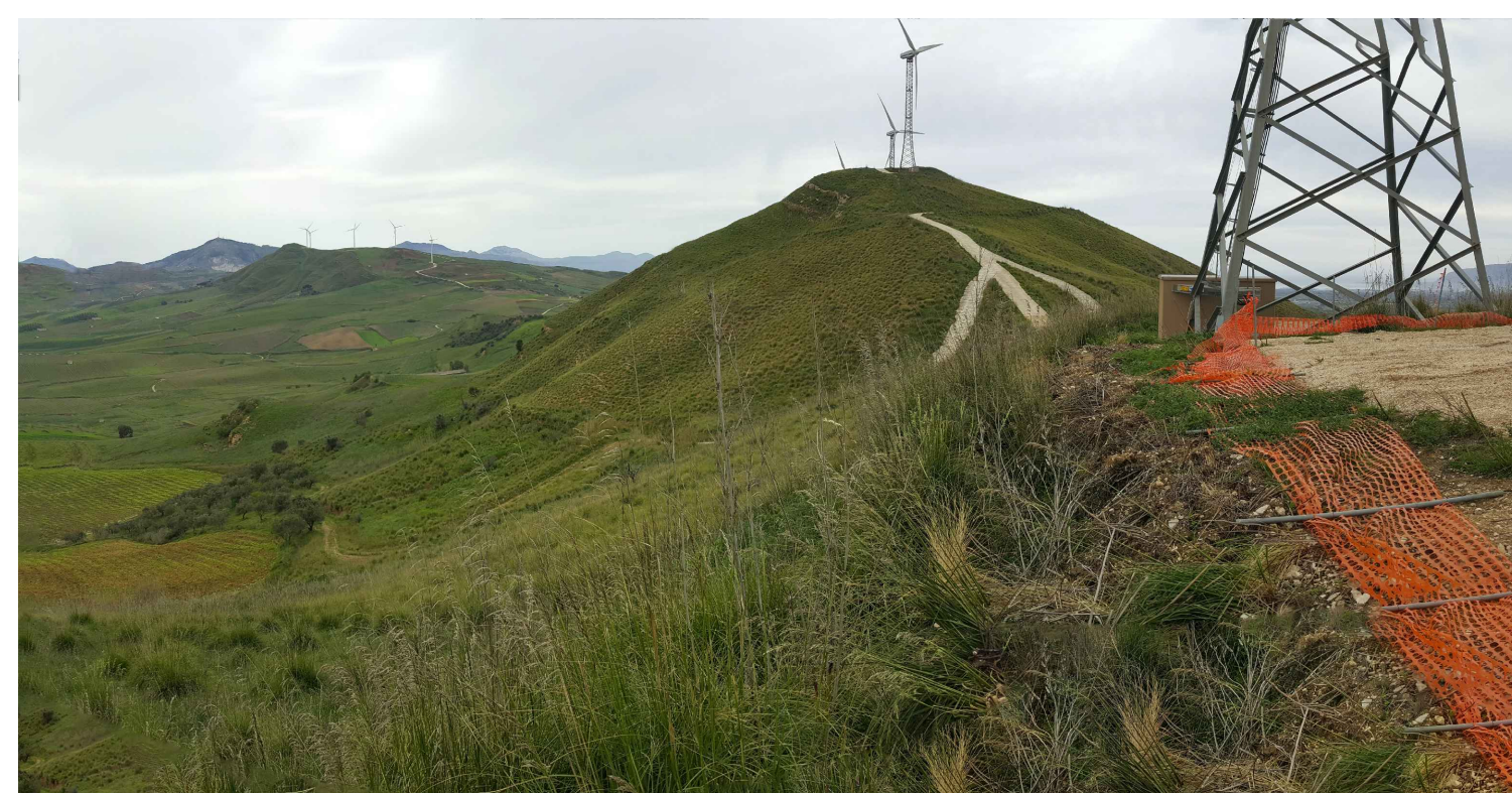
PVF3 - Stato Attuale
