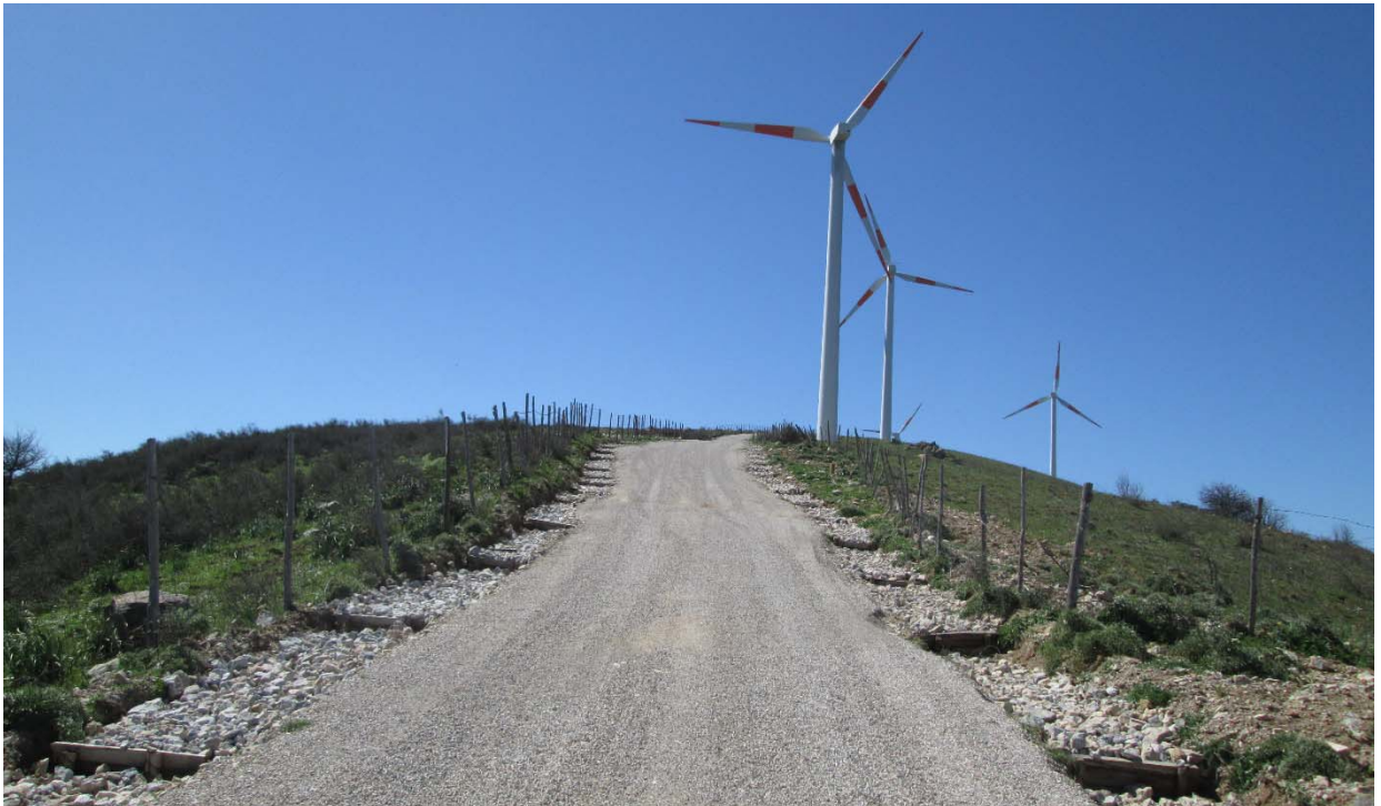
Sistema di fossi di guardia con fondo rivestito in pietrame e briglie.
