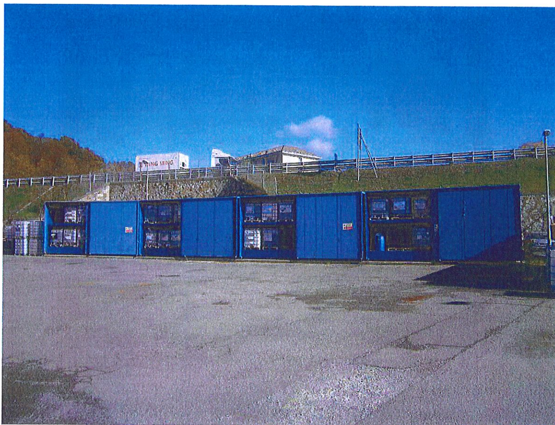
Figura 1: deposito additivi piazzale ingresso
