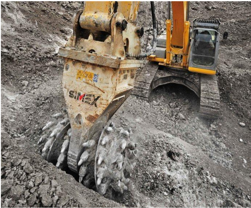
Figura 7-2: Escavatore cingolato dotato di fresa per gli scavi in roccia
