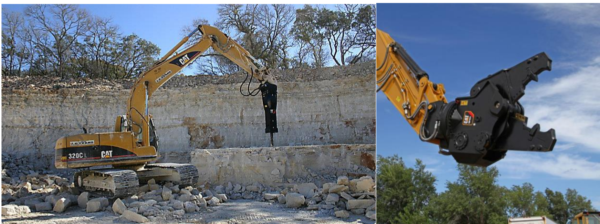
Figura 7-3: Escavatore cingolato dotato di martello demolitore (a sinistra) e di pinza demolitrice (a destra)
