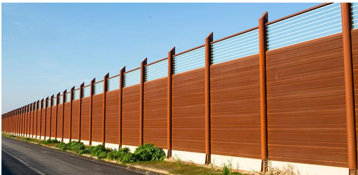
Figura 4-11: Esempio di barriera antirumore in corte e PMMA
