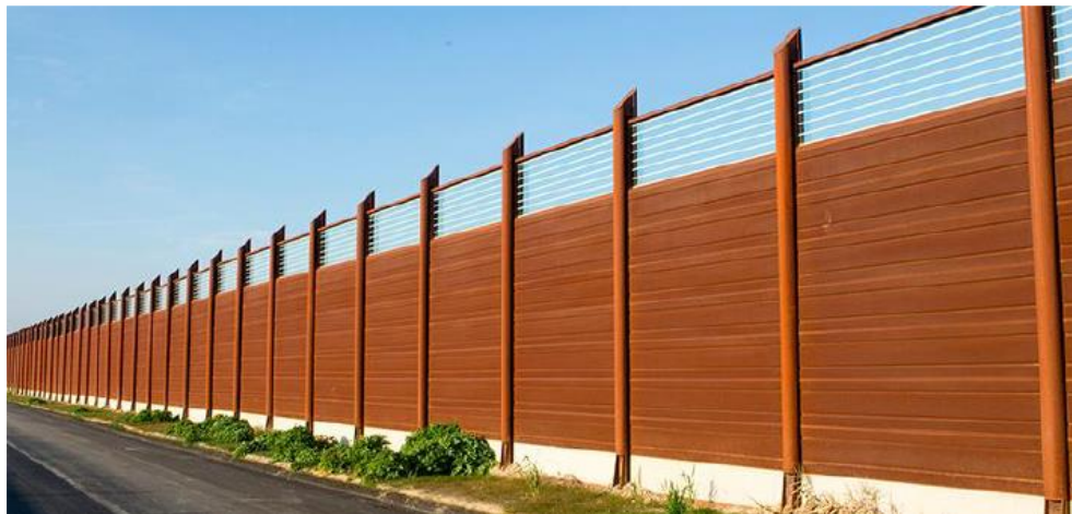
Figura 43. Esempio di barriera antirumore in cor-ten e PMMA
