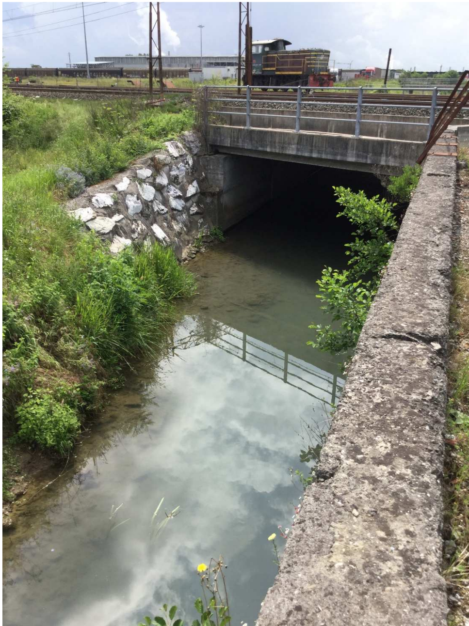
Rio del Frizzone – ponte ferrovia LU-PI lato monte
