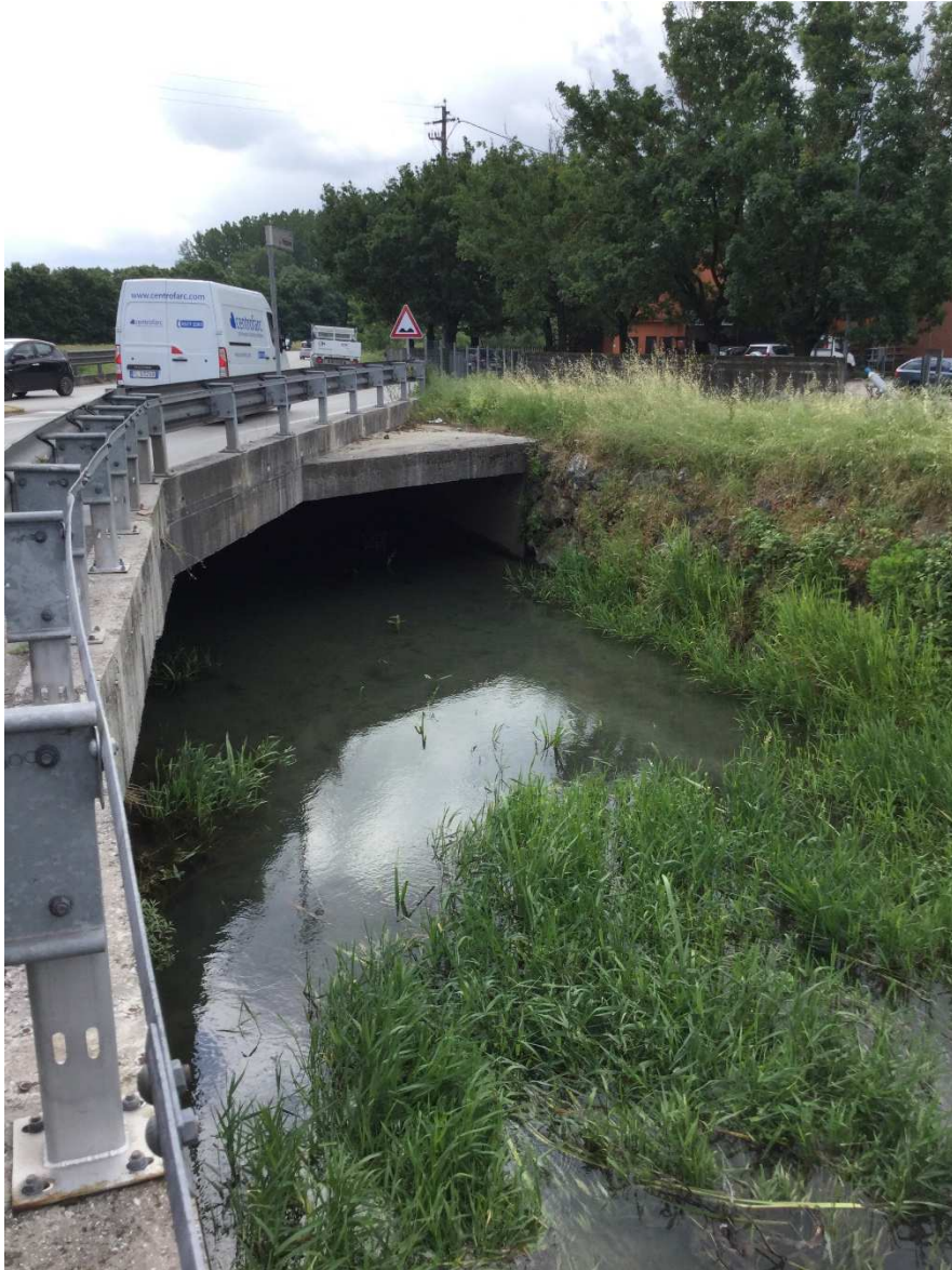
Attraversamento Rio del Frizzone sotto Strada del Frizzone – vista da monte
