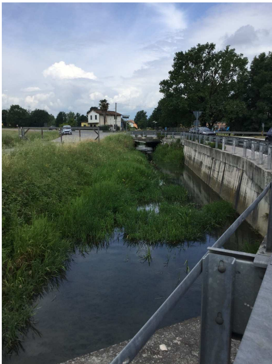
Attraversamento Rio del Frizzone sotto Strada del Frizzone – vista valle
