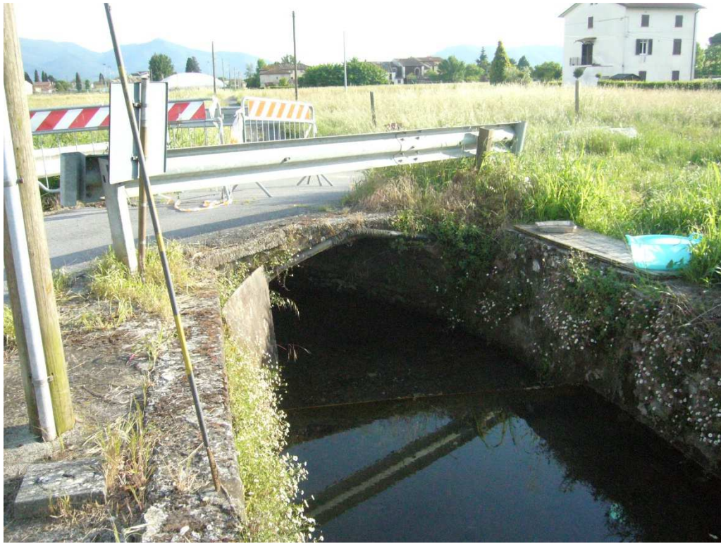
Canale Fanuccio – attraversamento
