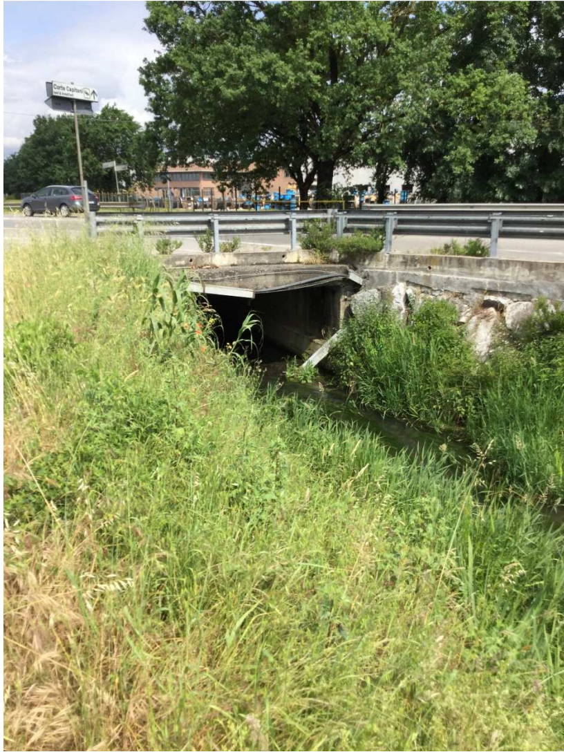
Attraversamento Rio del Frizzone S.P. Romana – valle
