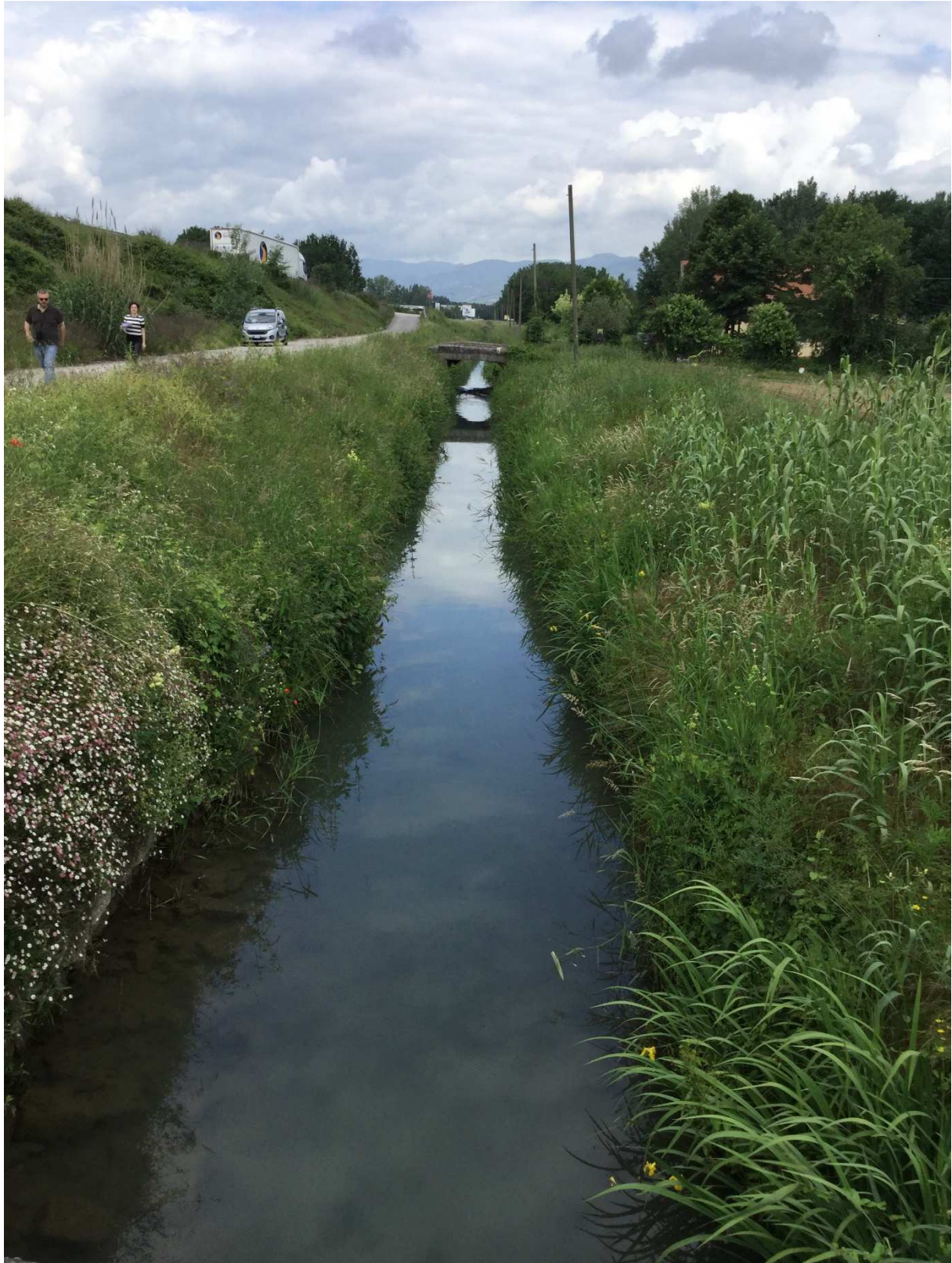
Rio del Frizzone – a monte della ferrovia LU-PI
