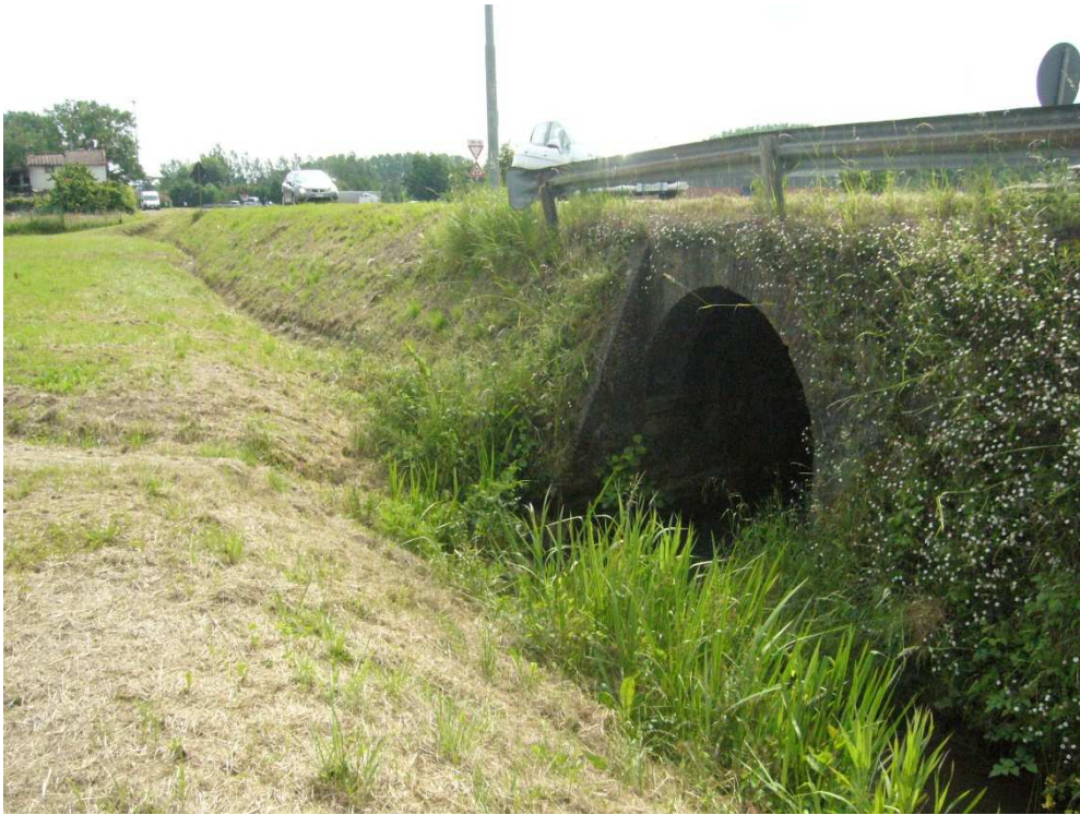
Attraversamento Rio Arpino sotto S.P. Romana – monte
