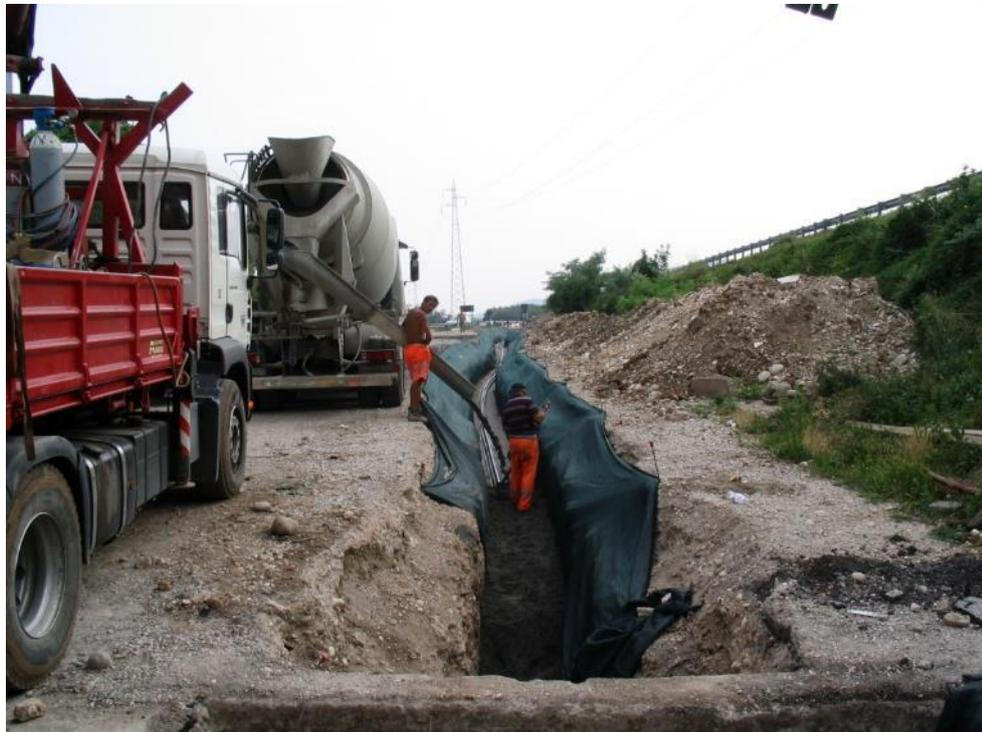
**Fig.9-2: posa del cavo AT: fase di gettata del cemento magro all'interno dello scavo**
