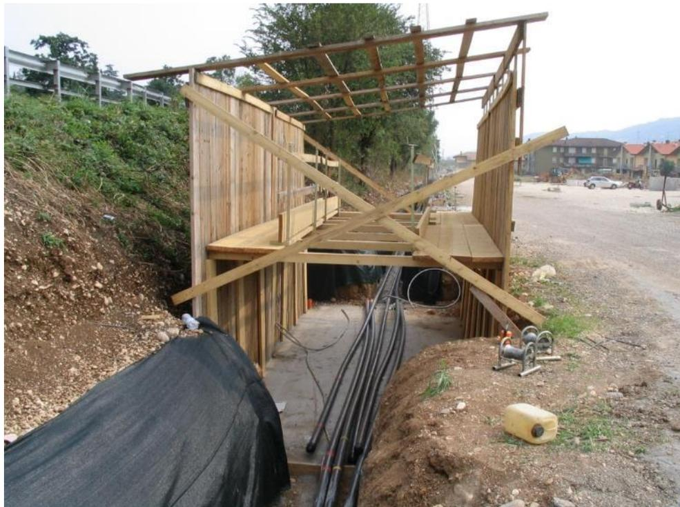
**Fig.9-3: allestimento copertura provvisoria per realizzazione giunti**
