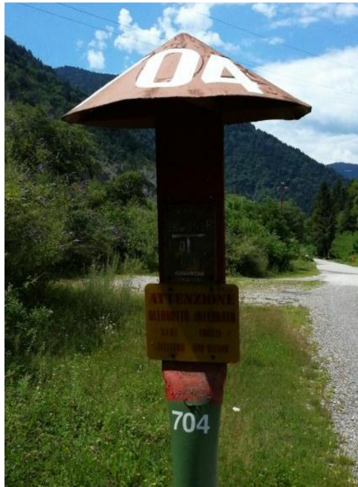
Figura 6: dettaglio sfiato oleodotto SIOT
