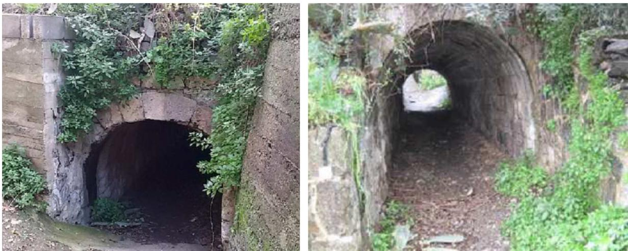
L’opera esistente è costituita da un tombino ad arco in muratura. La sezione di monte ha una larghezza di 2.0 m e un’altezza dei piedritti di 1.02 m . La sezione di valle ha una larghezza di 2.0 m e un’altezza di 1.22 m. La sezione risulta insufficiente da un punto di vista idraulico.
