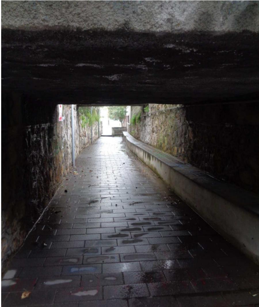
L’opera esistente è realizzata con spalle in muratura ed impalcato in c.a. che sostiene la linea storica. L’opera risulta inadeguata al transito della piena con tempo di ritorno di 200 anni.
