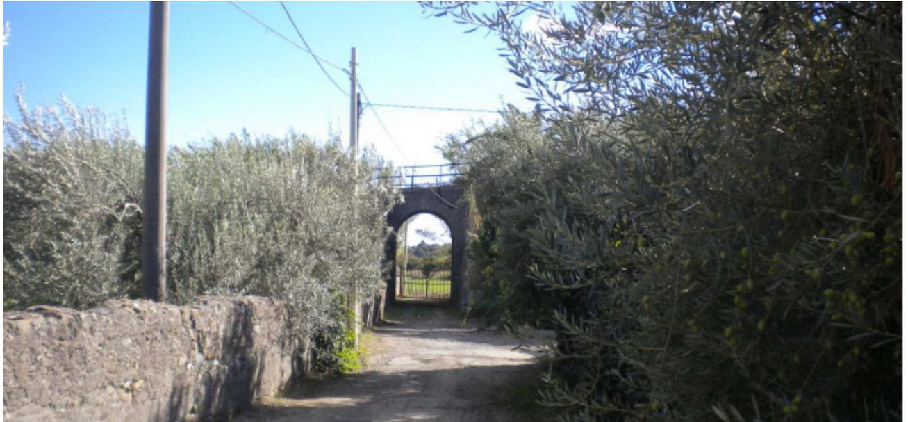
L’opera esistente è costituita da un ponte ad arco in muratura che sostiene la linea storica Alcantara-Randazzo, a singolo binario, dismessa. È prevista la demolizione dell’opera per consentire la realizzazione della pila del viadotto VI02 in progetto.
