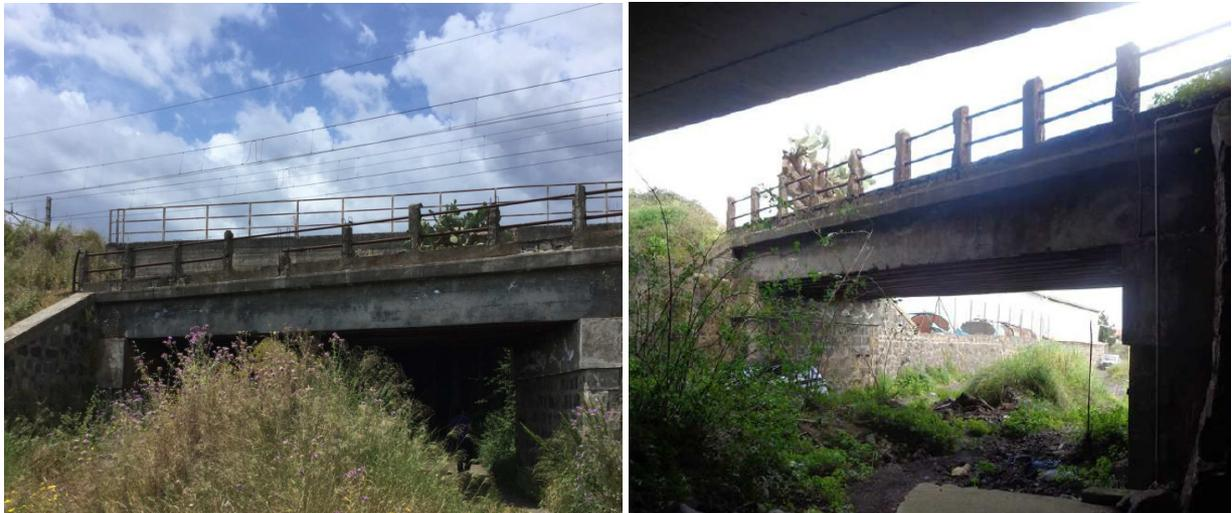
L’opera esistente è costituita da un ponte a travi incorporate che sosteneva la linea storica, a singolo binario, già dismessa in occasione del raddoppio. È prevista la demolizione dell’opera in oggetto per garantire il necessario franco idraulico richiesto a seguito della risistemazione idraulica del torrente delle Forche.
