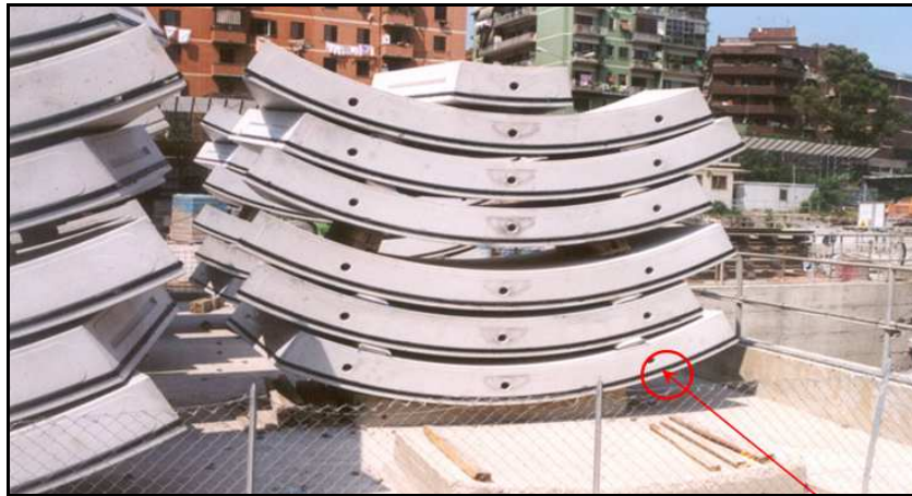
Figura 7– Conci prefabbricati con guarnizioni in neoprene a tenuta idraulica
