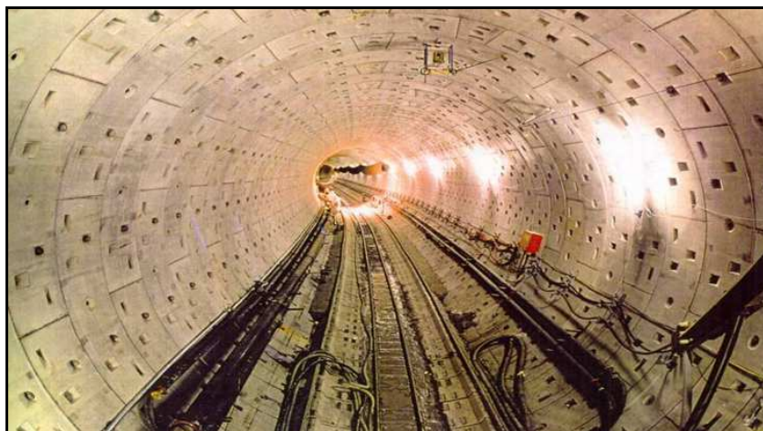
Figura 8– Galleria realizzata con TBM
