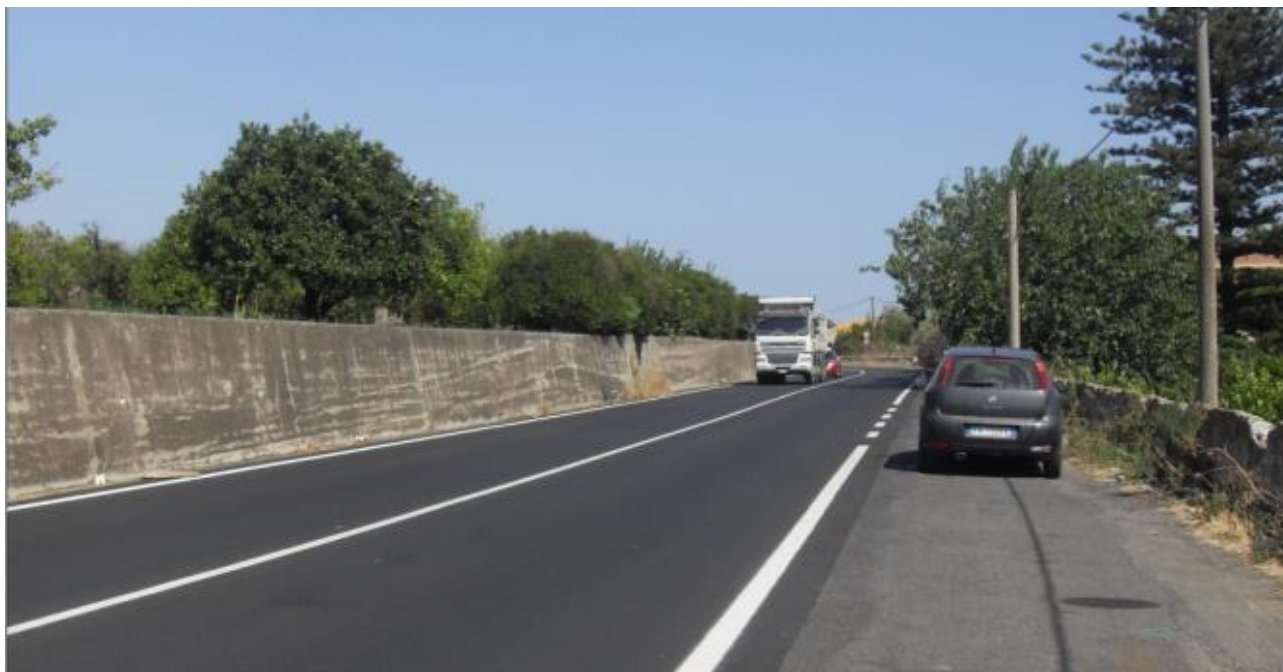
Foto 4 – Accesso successivo dalla S.S. 185 dopo aver demolito il muro esistente
