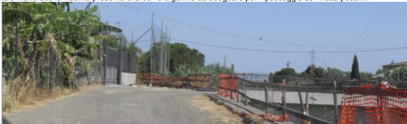
Ponte su Contrada Santa Venere – Vista curva a gomito di ingresso al manufatto
