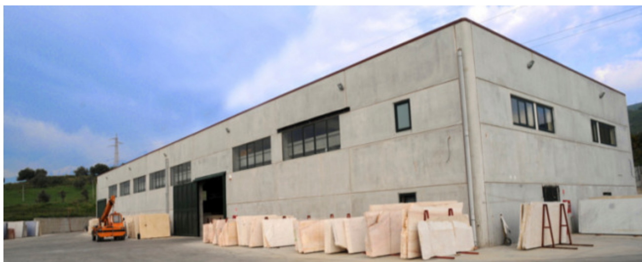
Foto 1 – vista del fabbricato oggetto di demolizione
