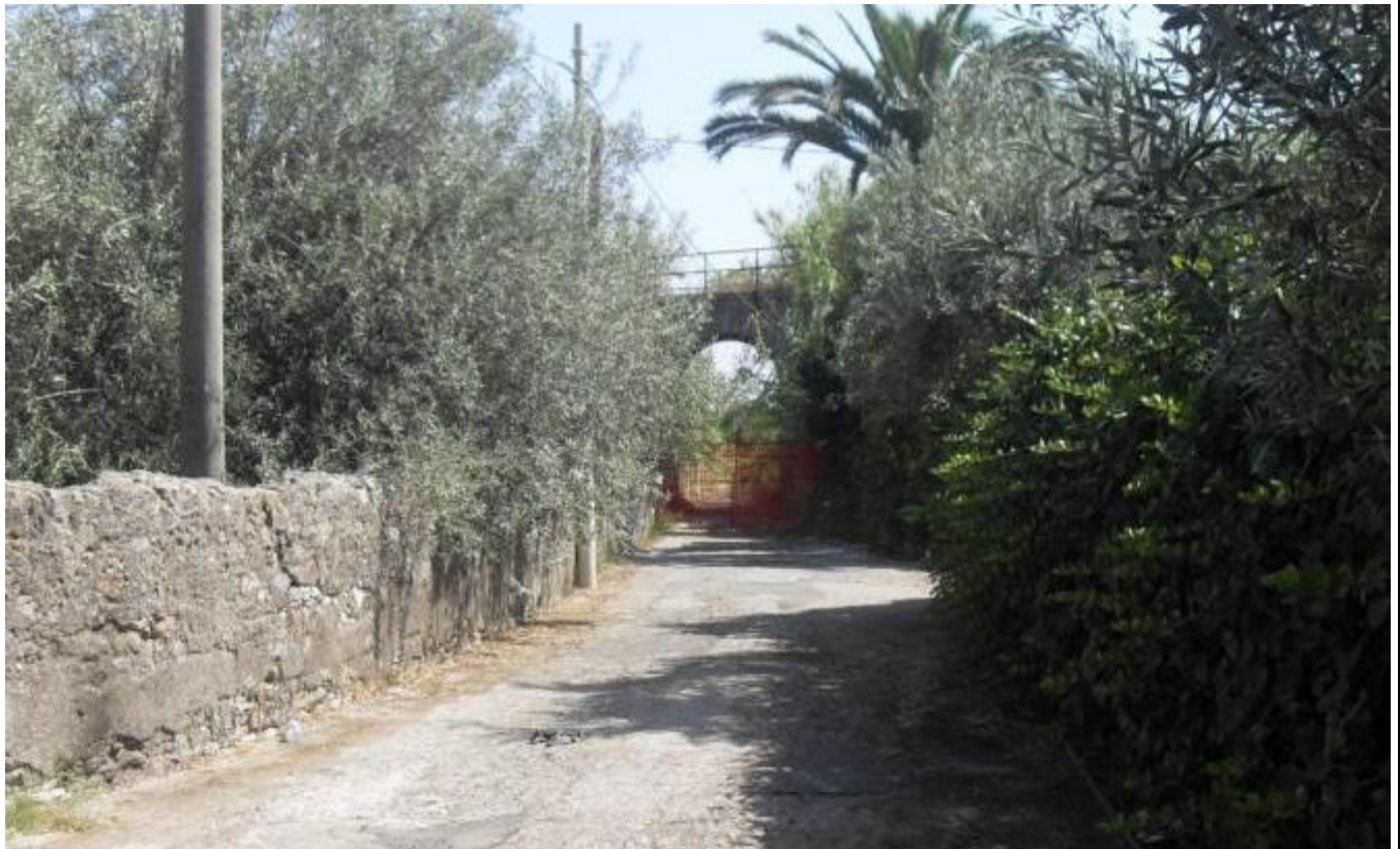
Foto 2 - vista della pista esistente per il sottopassaggio iniziale della linea dismessa Alcantara-Randazzo
