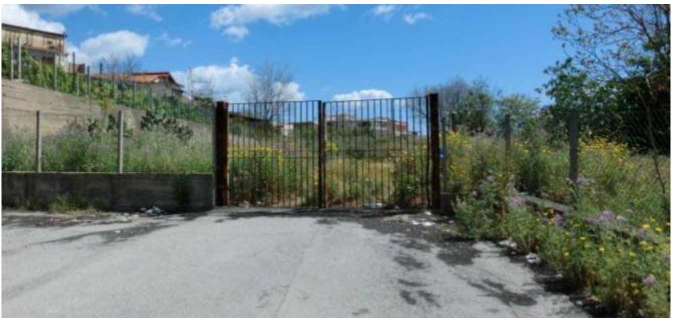
Cancello di accesso su via Civi
