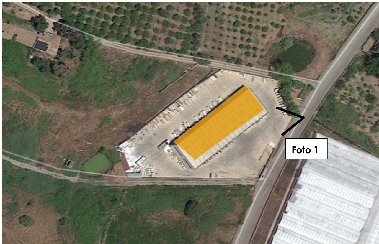
Vista aerea del cantiere AT04.1 (in corrispondenza al piazzale pavimentato esistente attualmente ad uso industriale – vista del fabbricato oggetto di demolizione)
