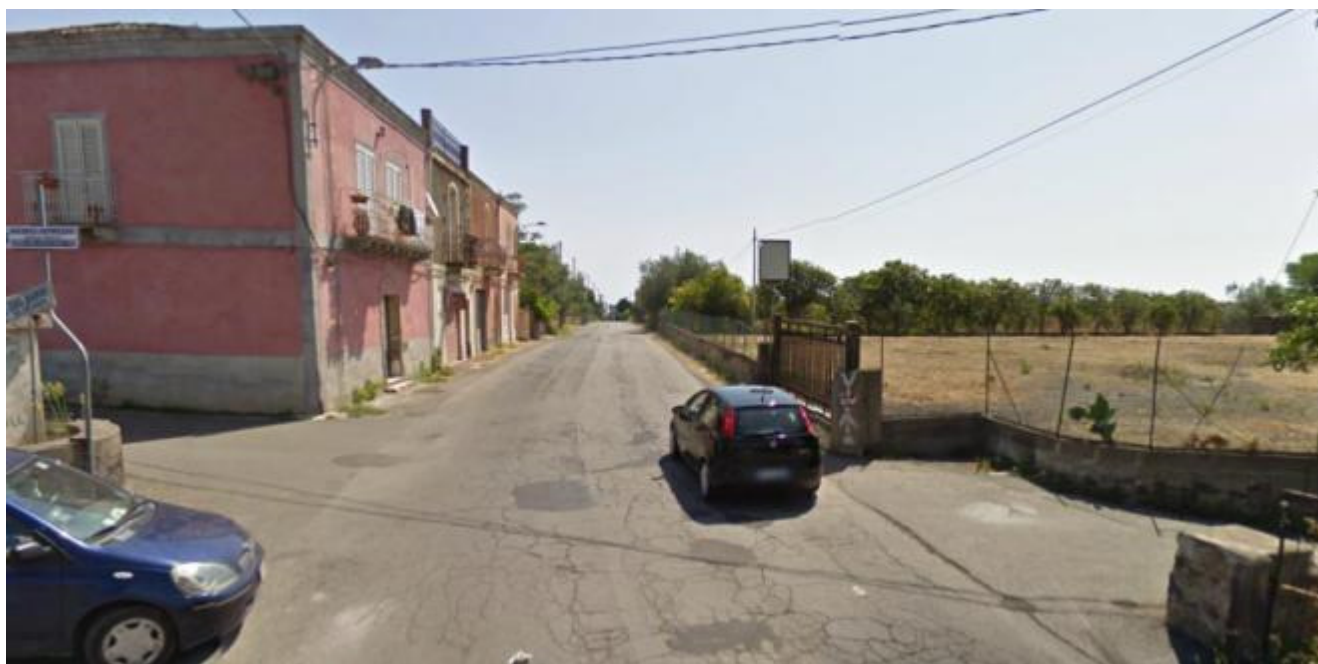
Foto 2 - vista area di cantiere dalla SP 186
