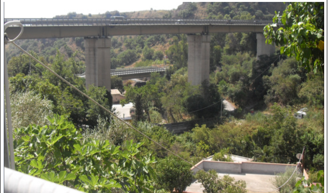
Foto 1 (vista dell'area di intervento e del fabbricato da demolire)
