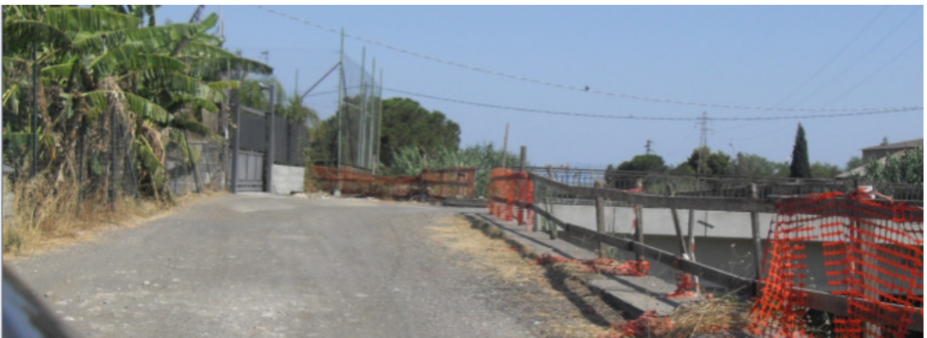
Ponte su Contrada Santa Venere – Vista curva a gomito di ingresso al manufatto
