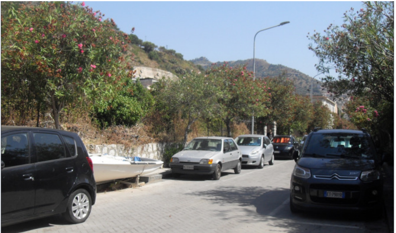
Foto 1 – Vista dell'area tecnica AT17.1 dalla viabilità di accesso
