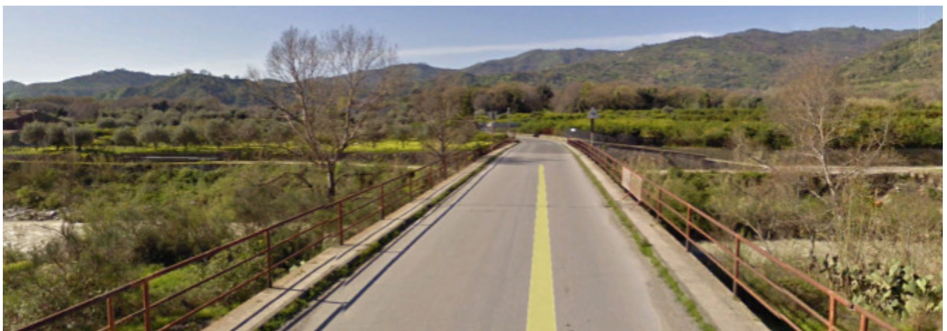
Ponte di collegamento S.P.81 – S.S.185 alla'altezza dell'abitato di Gaggi.
