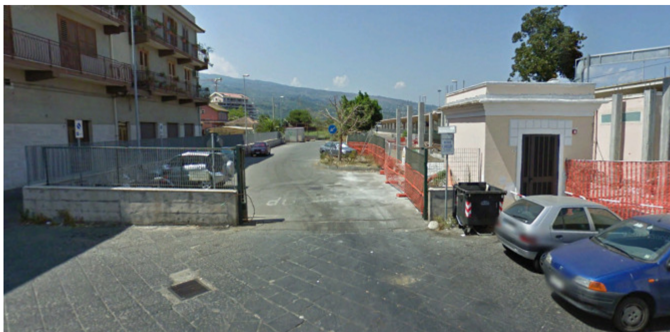
Foto 1 (vista eccesso di cantiere CA01.1 B)
