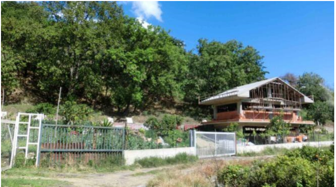
Foto 2 – Fabbricato esistente da demolire
