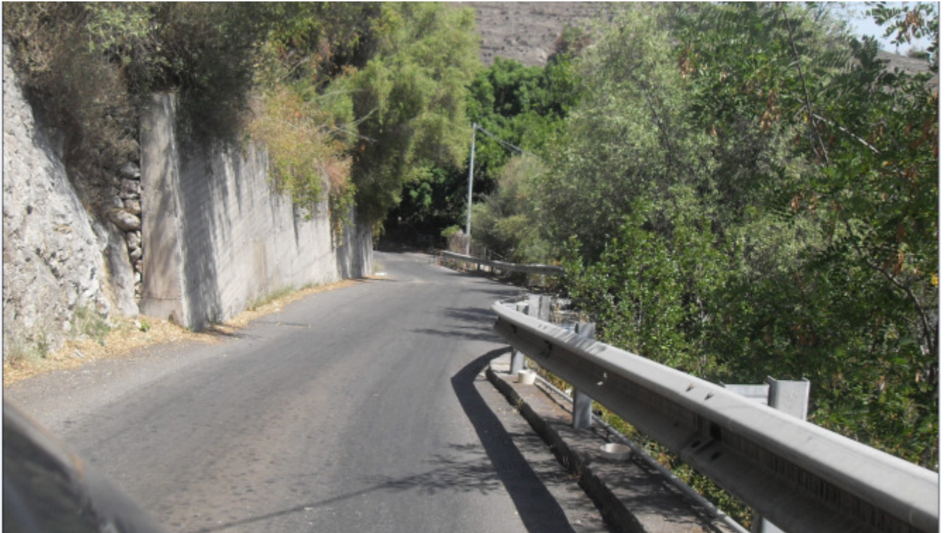
Foto 8 - vista viabilità di collegamento aree AT14.1 e AT15.1 a forte pendenza
