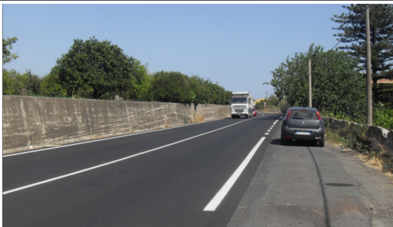
Foto 4 – Accesso successivo dalla S.S. 185 dopo aver demolito il muro esistente
