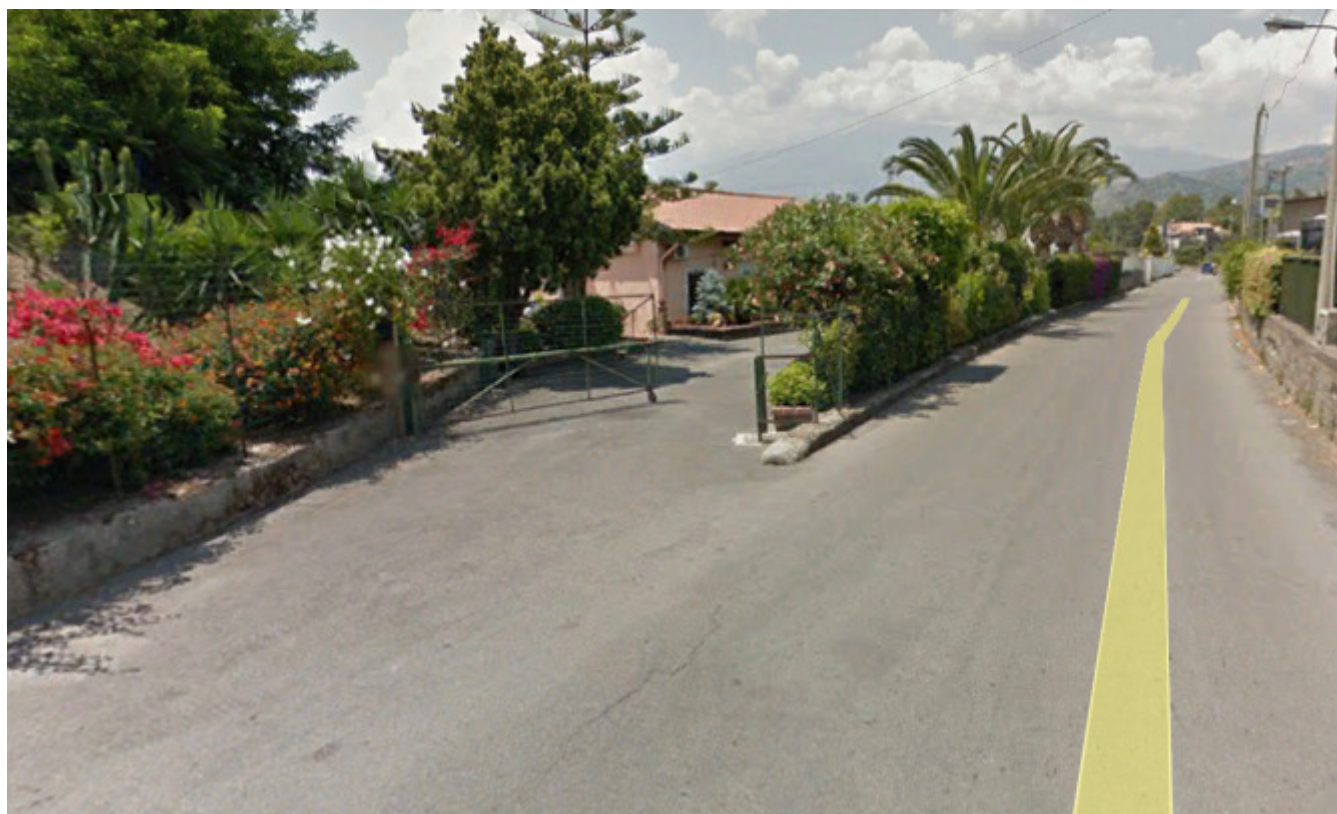
Cancello di accesso al CA03.1
