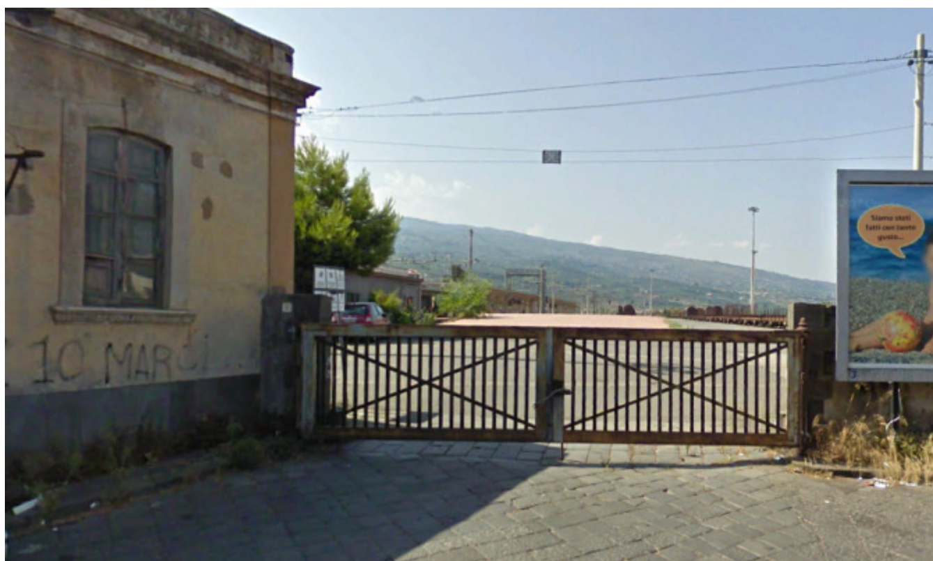
Foto 1 (vista eccesso di cantiere CA01.1 A)
