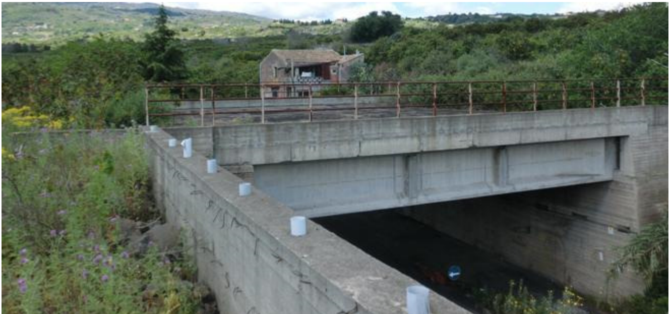
Ponte di collegamento tra il CO01.1 e l'AT01.1
