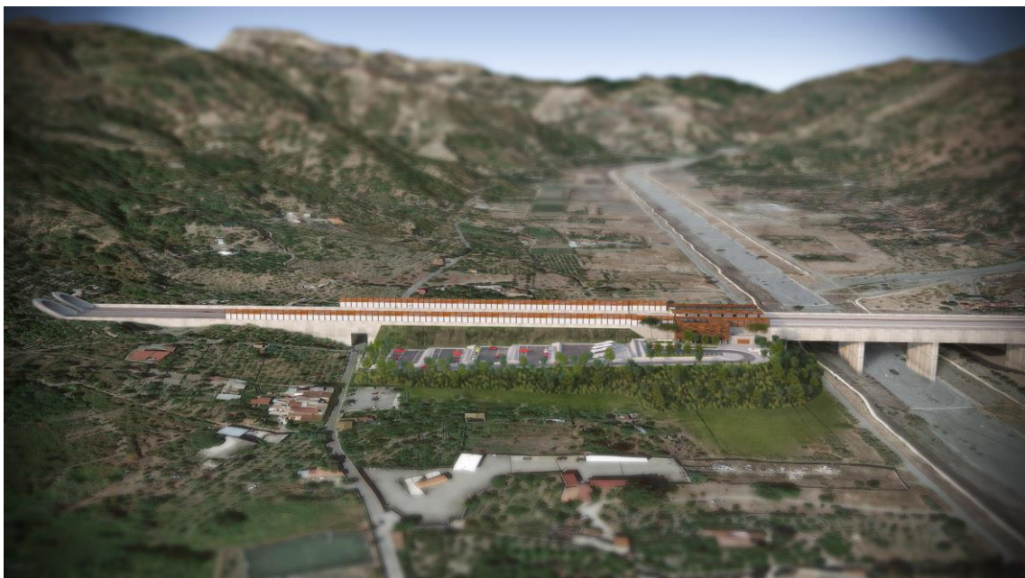
VI05 - Viadotto fiumara d'Agro (da pk 23+136 a pk 23+486)
