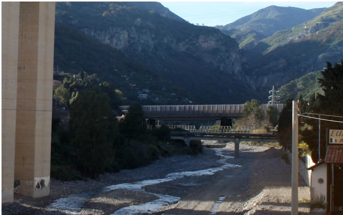
VI03 - Viadotto Letojanni (da pk 16+036 a pk 16+279)
