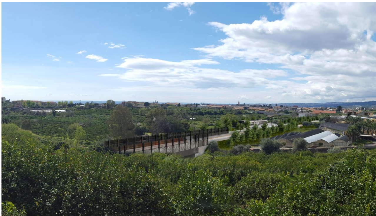
VI01 - Ponte sul torrente Fogliarino (da pk 2+945 a pk 2+977)
