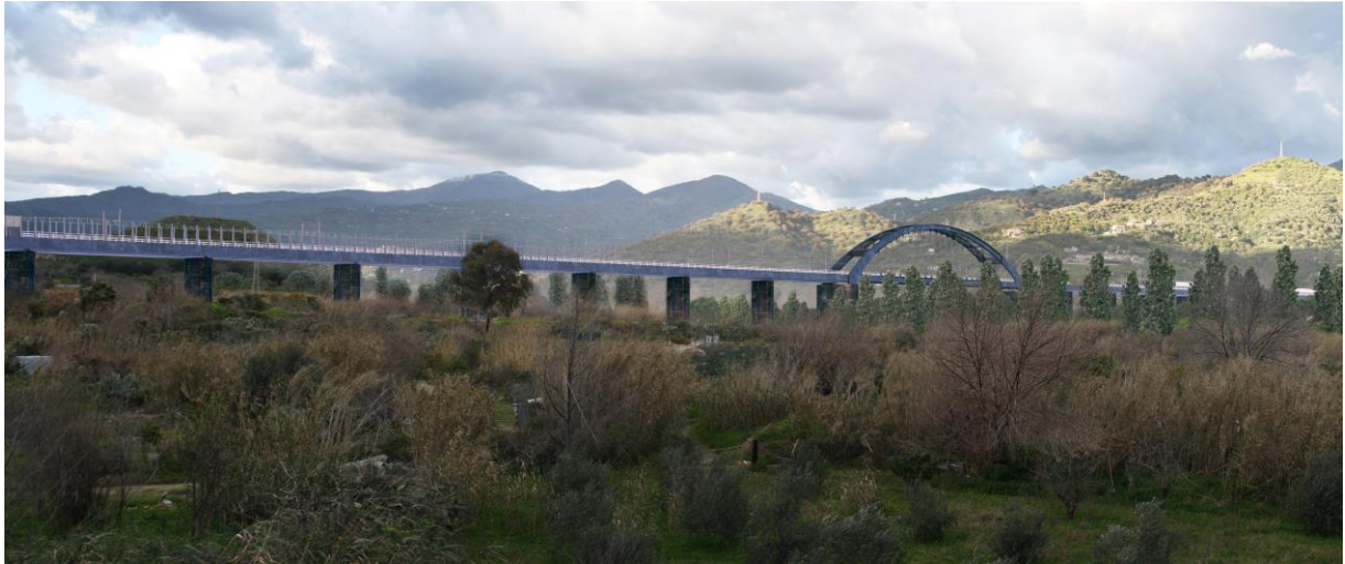
VI02 - Viadotto Alcantara (da pk 6+592 a pk 7+530)
