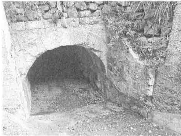
Denominazione Bene Tombino ad arco Km 319+507 Comune MESSINA Didascalia Vista da Nord
