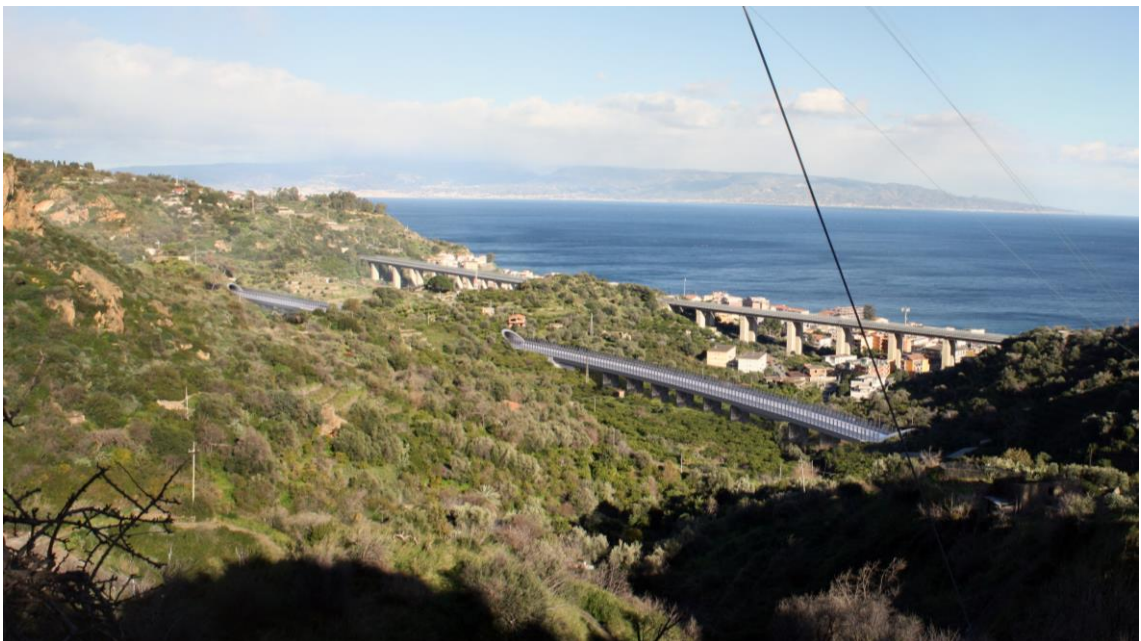
VI07 - Viadotto Satano (da pk 33+976 a pk 34+250) e VI08 - Viadotto Ali (da pk 34+564 a pk 34+634)
