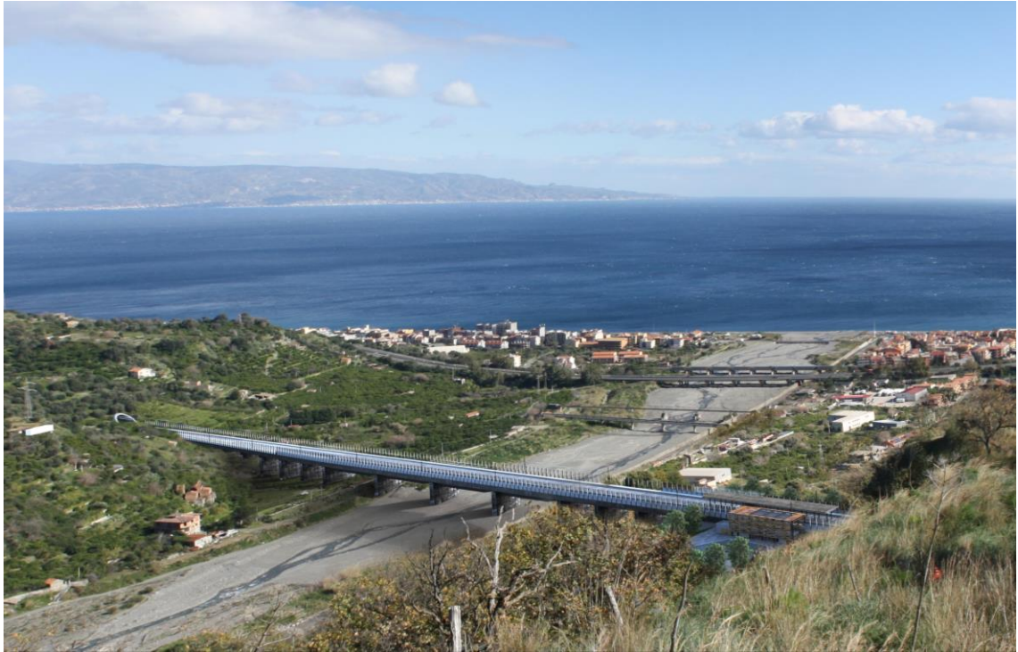
VI06 - Viadotto Fiumedinisi (da pk 32+862 a pk 33+412)
