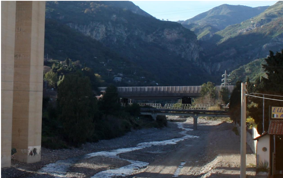
VI03 - Viadotto Letojanni (da pk 16+036 a pk 16+279)
