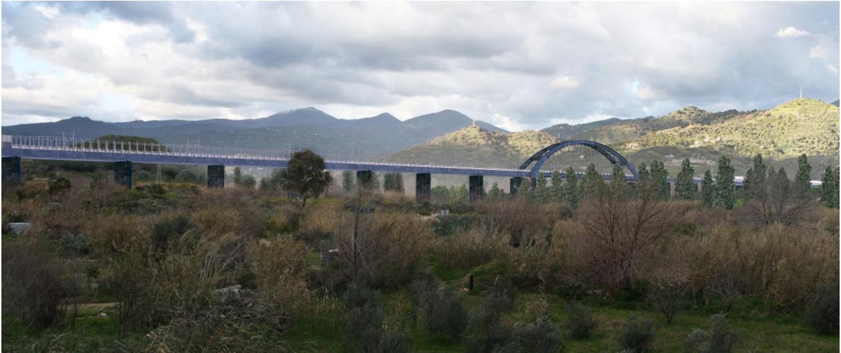
VI02 - Viadotto Alcantara (da pk 6+592 a pk 7+530)
