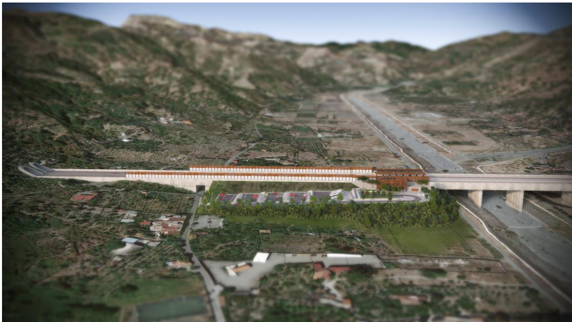
VI05 - Viadotto fiumara d'Agro (da pk 23+136 a pk 23+486)
