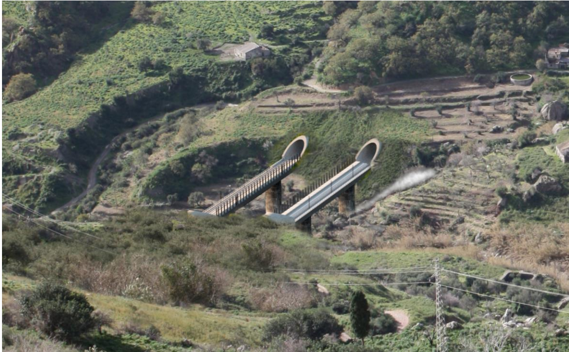
VI04 - Ponte sul torrente Fondaco Parrino (da pk 20+188 a pk 20+277)
