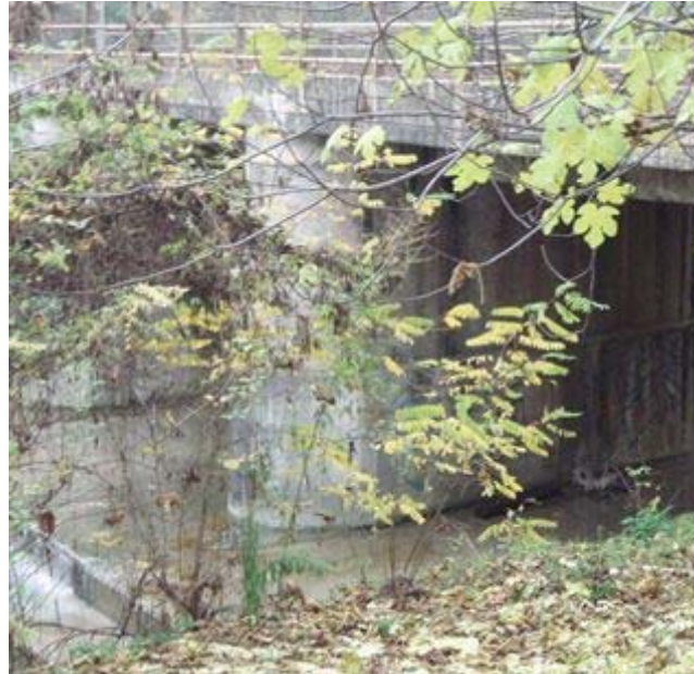
FIGURA 3 - PONTE FF.SS. SU T. CROSTOLO
