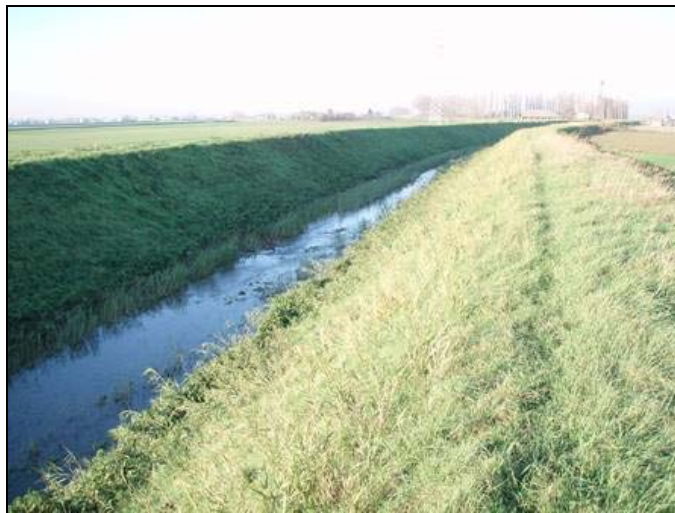
FIGURA 1 - TORRENTE QUARESIMO IN CORRISPONDENZA DELL'ATTRAVERSAMENTO IN PROGETTO
