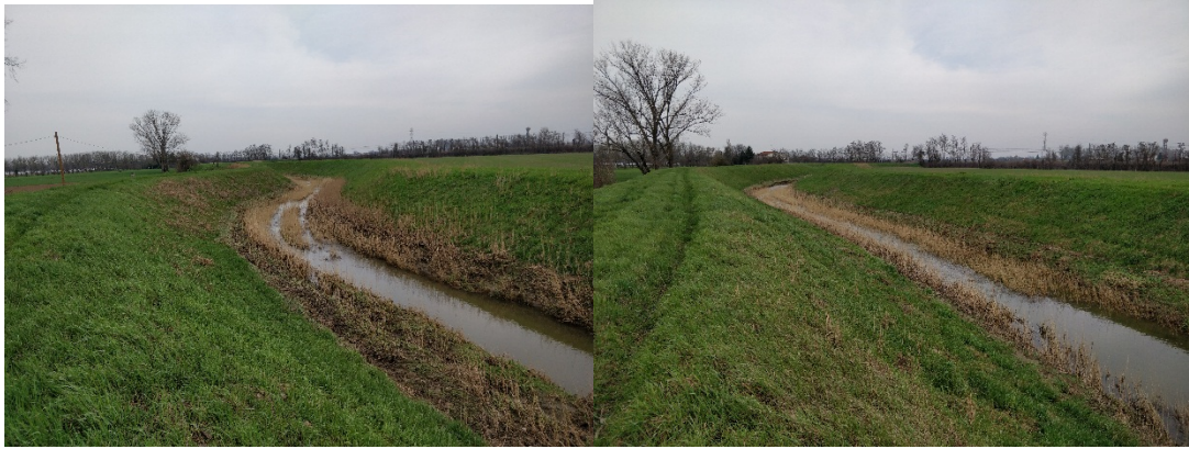
FIGURA 13 -. STATO ATTUALE DEL CORSO D'ACQUA TRA LE SEZZ. QUA_10 E QUA_9
