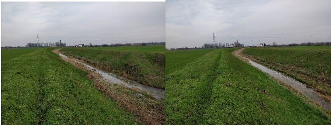
FIGURA 16 -. STATO ATTUALE DEL CORSO D'ACQUA TRA LE SEZZ. QUA_7 E QUA_6
