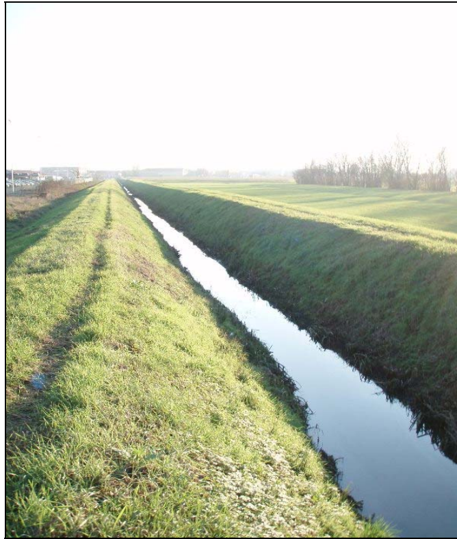
FIGURA 1 - FOSSETTA DELLA TORRETTA A VALLE DELLA SEZIONE D'INTERFERENZA CON LA STRADA IN PROGETTO
