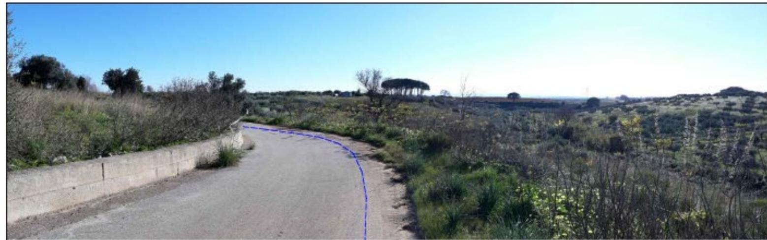
Il cavidotto in progetto per l'Aerogeneratore PESE02 attraversa un'area boschiva come da succitata nota della Soprintendenza BB.CC.AA. . Si precisa che, come da viste soprariportate, tale attraversamento avviene esclusivamente su viabilità esistente asfaltata.
