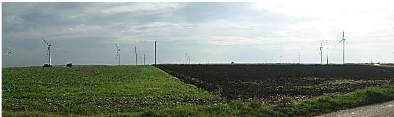
Punto di ripresa O: area impianto vista da ovest (SP6)
