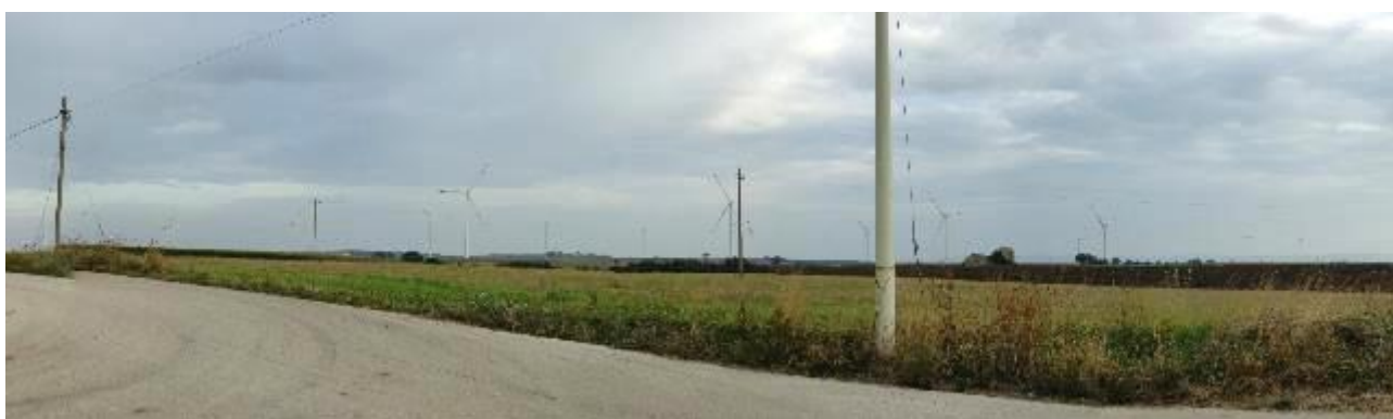
Punto di ripresa P: area impianto vista da sud (viabilità interpoderale)
