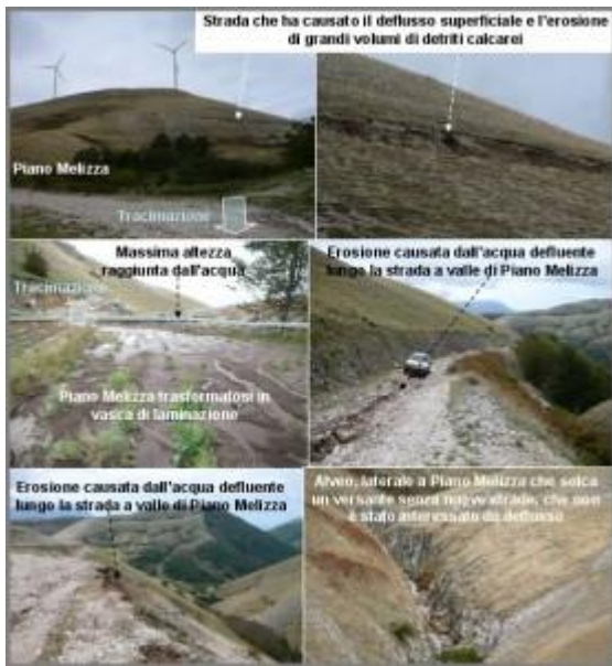
Figura 4: Esempio di inadeguata realizzazione di strade che
