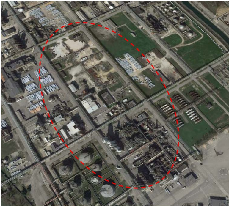
Figura 3.3 Area di intervento all'interno dello Stabilimento Versalis (cerchio rosso)
