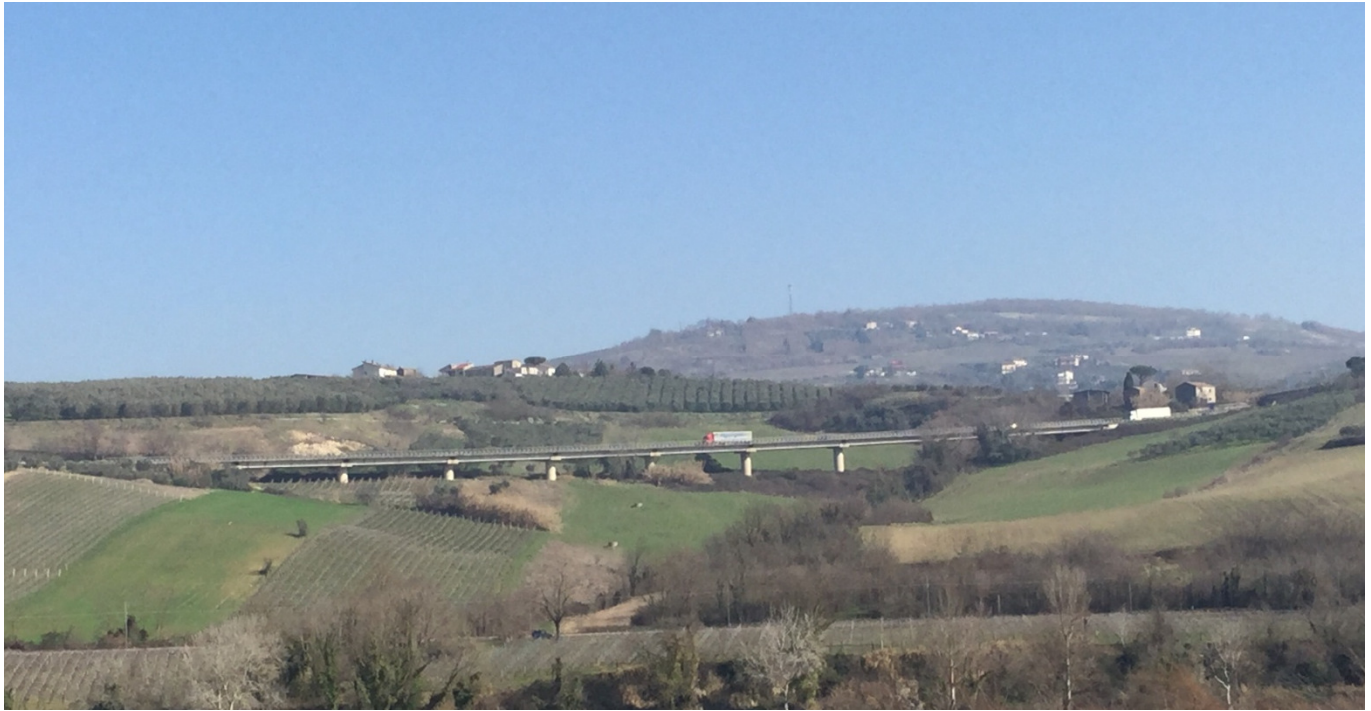
Foto 12- Vista panoramica del vallone su cui insiste l'imbocco lato Benevento della Galleria Le Forche, interessato da movimenti franosi quiescenti nella parte alta e da deformazioni viscosi delle coltri in prossimità dell'opera.
