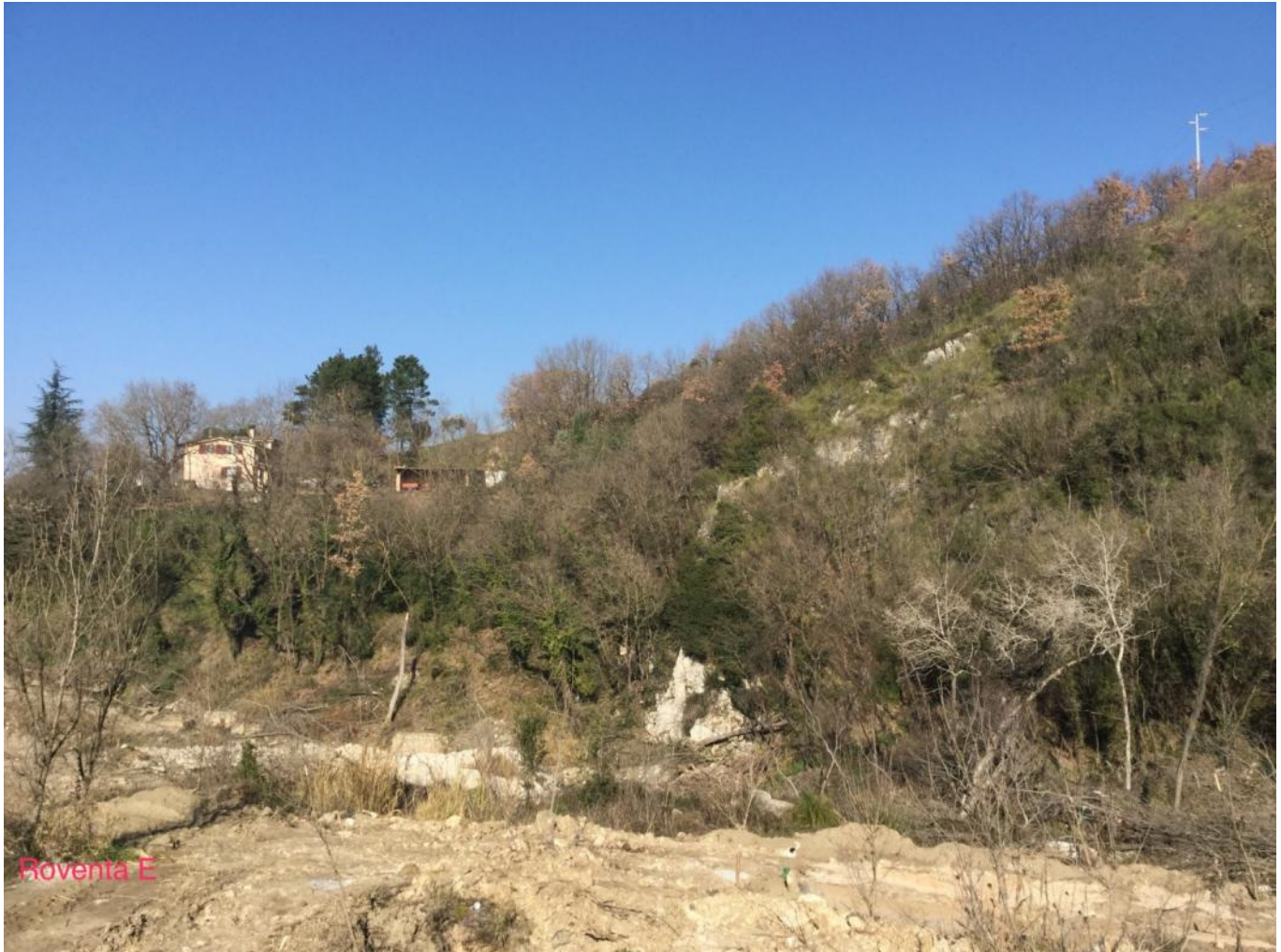
Foto 16 - Vista panoramica del versante dove è previsto l'imbocco sud-est della galleria Reventa.
