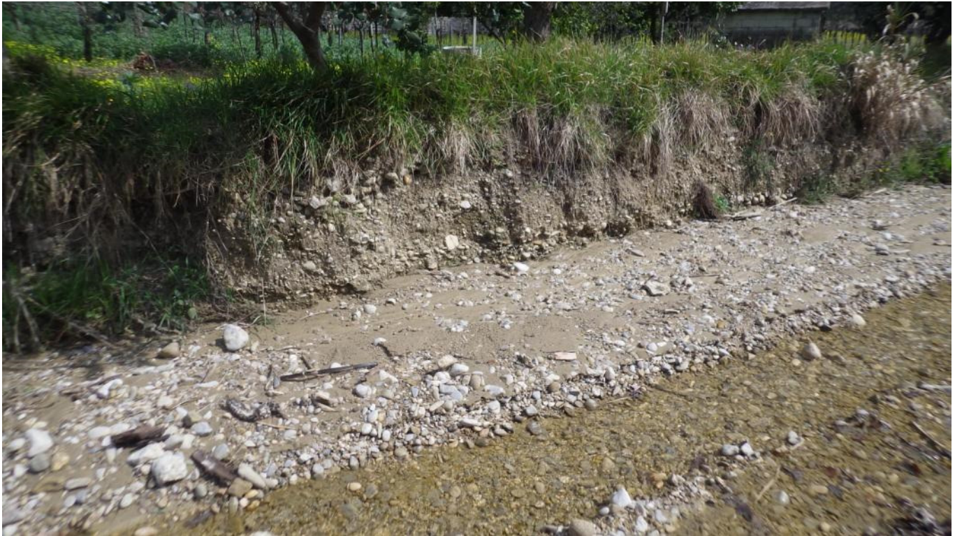
Foto 4 – Depositi alluvionali recenti (bb1) presenti in corrispondenza della conoide alluvionale a nord del Fiume Calore, in località Masseria Acquafredda, ad SW del centro abitato di San Lorenzo Maggiore.
