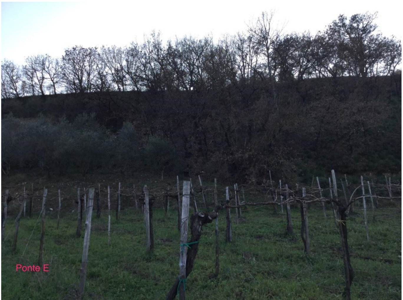
Foto 15 - Vista panoramica del versante dove è previsto l'imbocco est della galleria Ponte.
