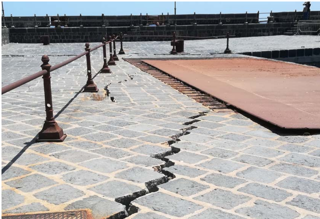
Figura 19 – Frattura della pavimentazione lavica esistente
