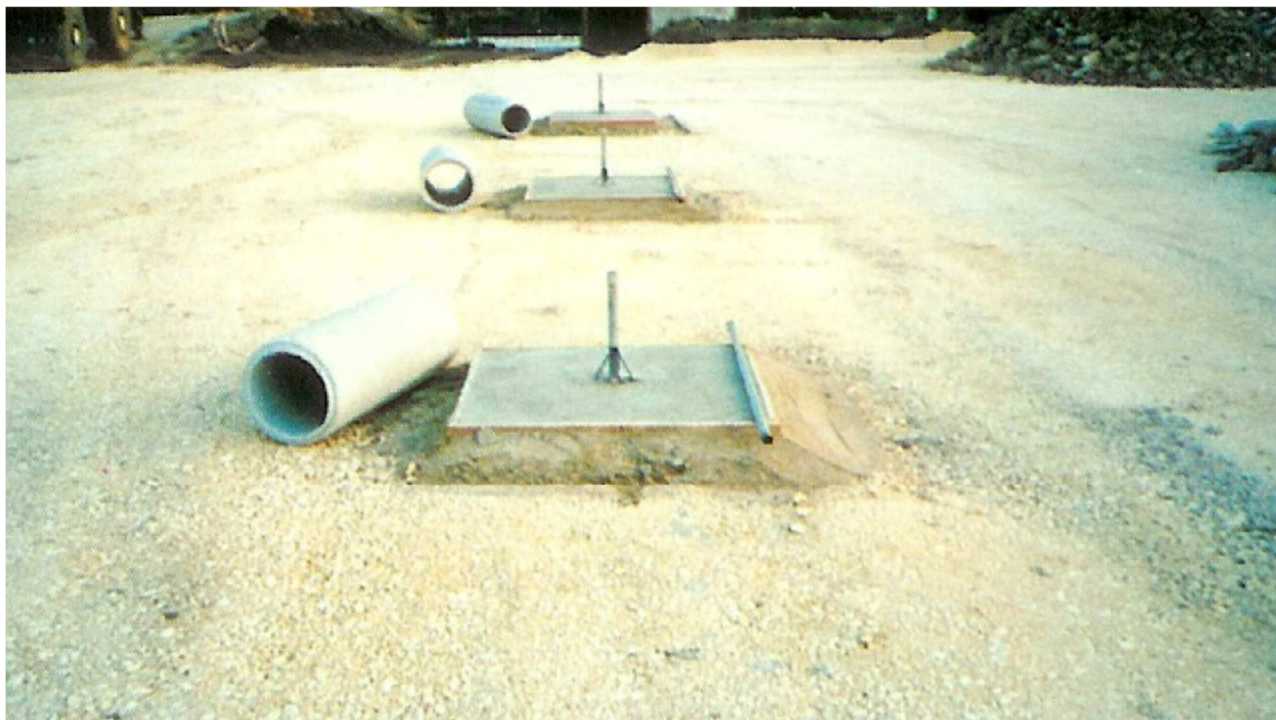
Figura 17. Esempio di posa di assestimetri a piastra, prima della messa in opera del rilevato di ripiena.
